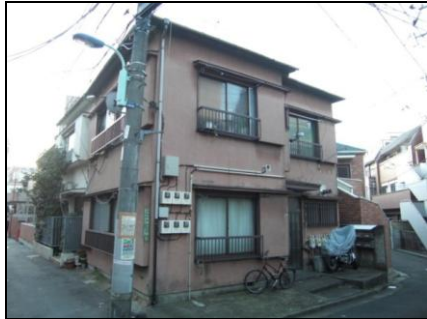
図3 モルタル住宅戸袋あり
