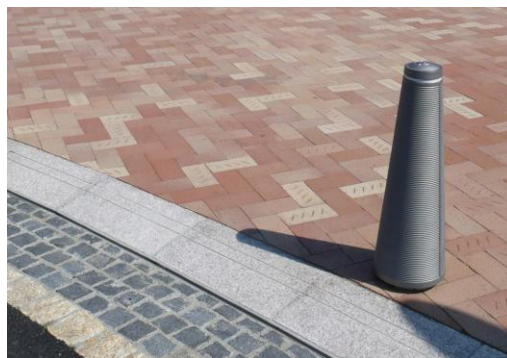
図-4 歩車道境界縁石（高さ 50mm のゼロ段差）
