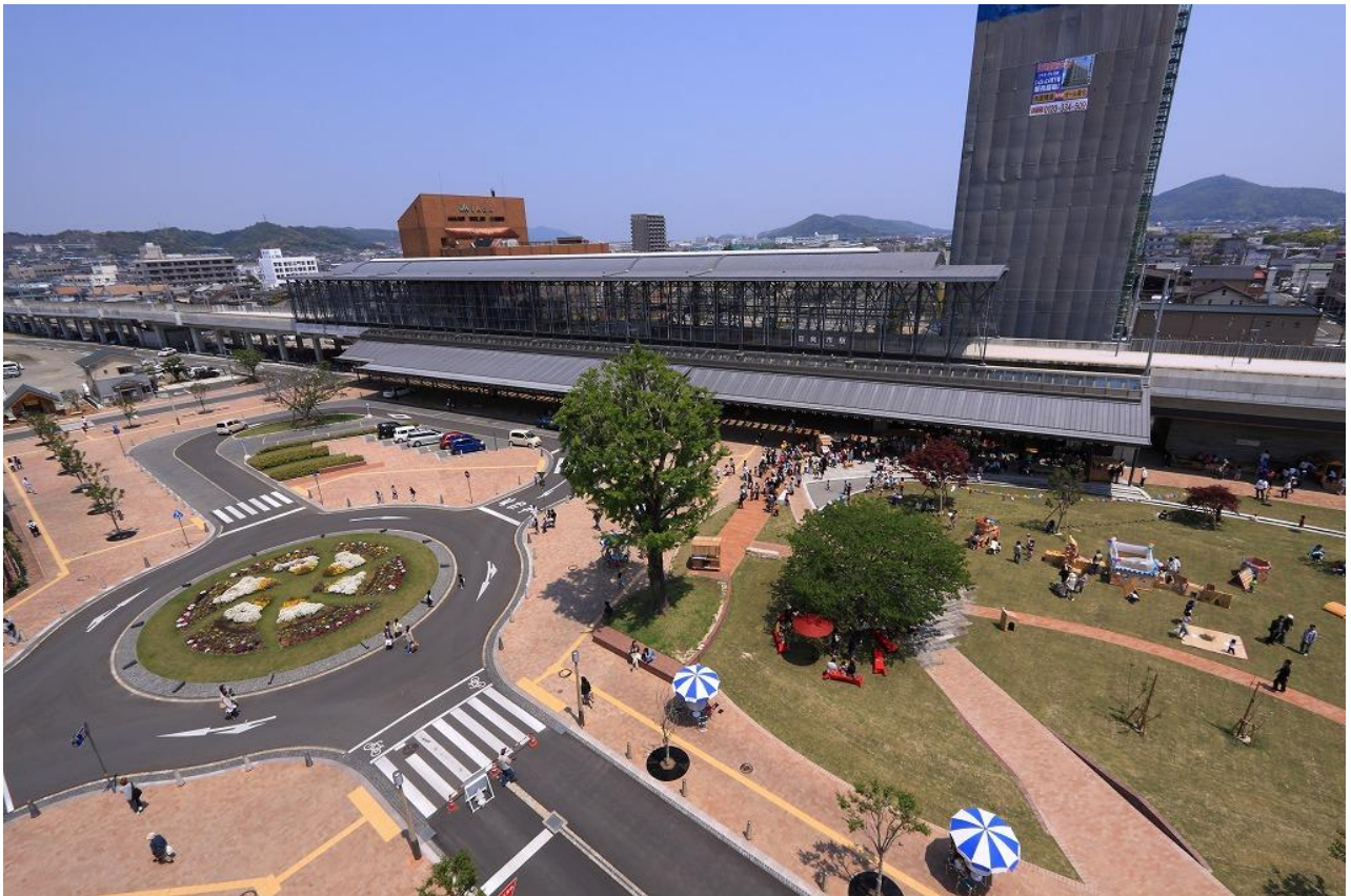
図-26 完成した日向市駅前広場
