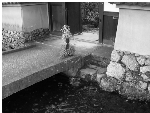
図-4 水路に面して設けられた洗い場 (社家I-2において 2007年12月20日筆者撮影)
