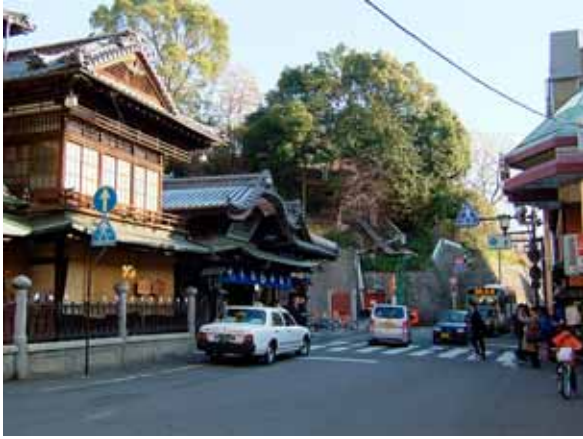
図-2 整備前の道後温泉本館正面
