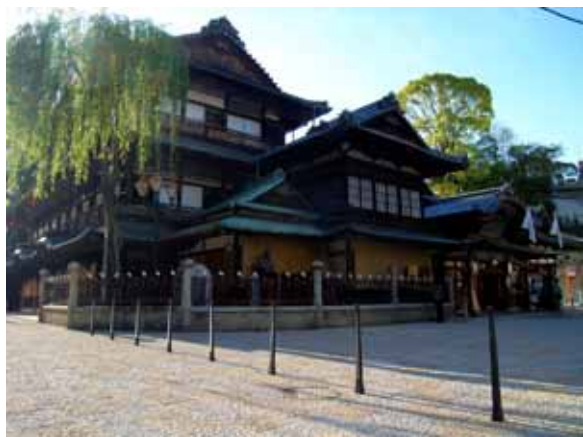
図-4 完成した道後温泉本館周辺広場
