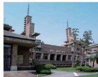
武庫大橋右岸上流側すぐ位置する旧甲子園ホテル（現在：武庫川学院甲子園会館）の現在の様子
