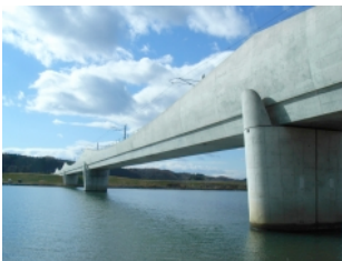
図-5 鳴瀬川橋りょう
