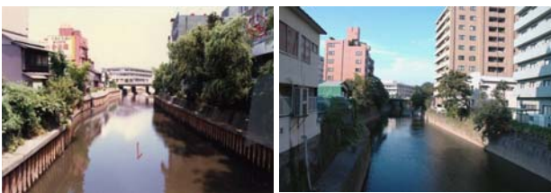
写真-3 1985年（昭和60）の矢板護岸 写真-4 現在の化粧板
