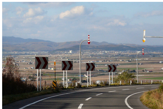
写真-4 シェブロン標識によって、前方の眺望が遮られている。事故の危険性が高いとされるカーブなどに設置している事例が多い
