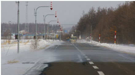
写真-9 防護柵が無く雪堤の形成は抑制される
