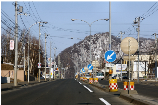
写真-3 中央分離帯の開口部で、断続的に標識とクッションドラムが設置され煩雑となっている
