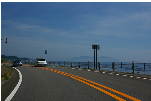
写真-6 景観への影響が小さいガードケーブルの事例
