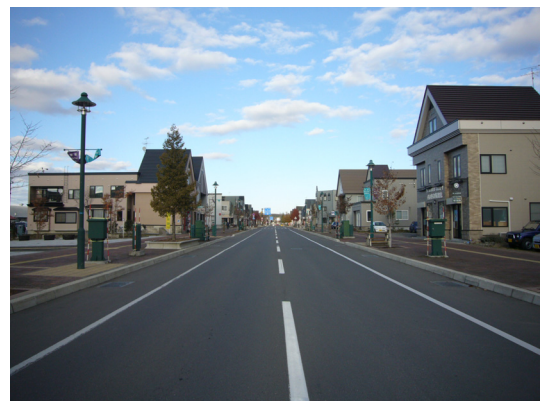
写真-12 電線地中化された町並み（実際）
