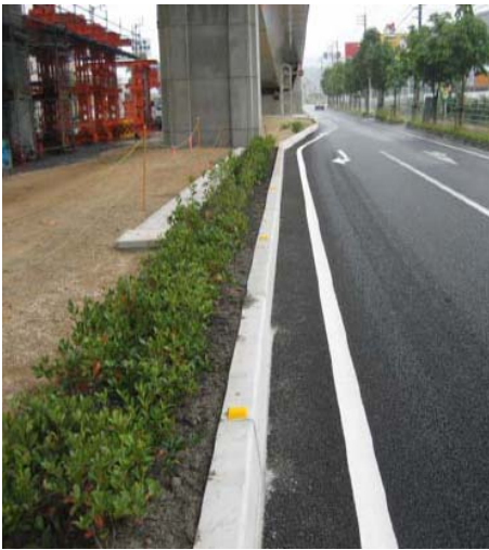
写真－4 高架橋下雨水貯留灌水システムの試験施工
