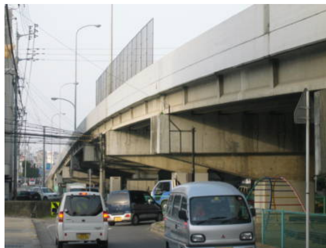
(写真1) 松山環状道路の立体交差、
