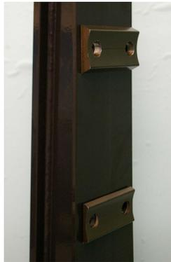
図-13 支柱と横梁の締結ための台座
