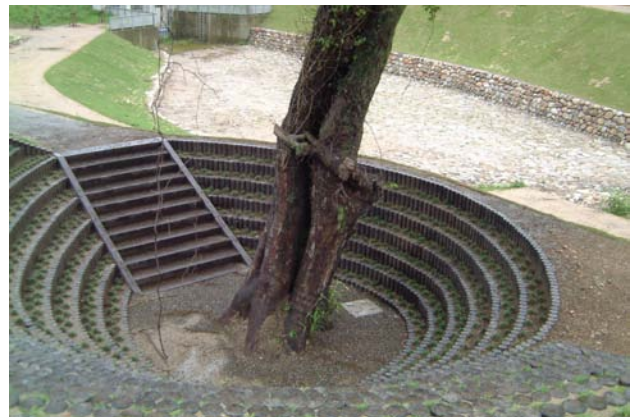
図-18：古木の状態（安易な保全措置）
