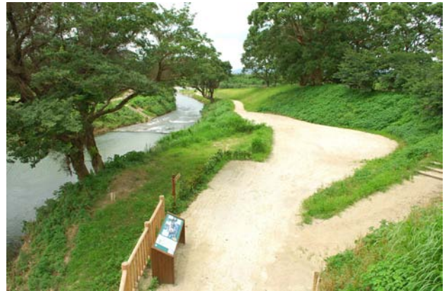
図 20：放水路の整備（写真右手が中の島）
