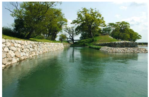
図-12：施行後（護岸を立て河畔林を保全）
