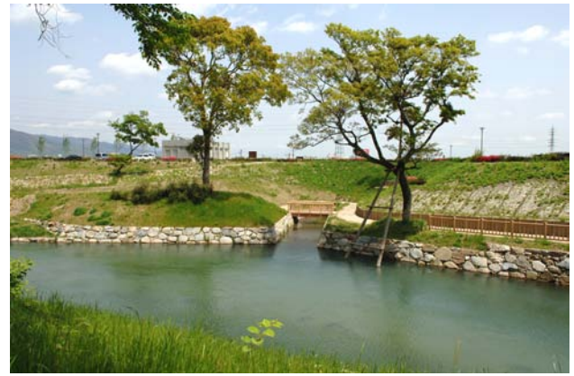
図-28：小寺川井樋取り入れ口
