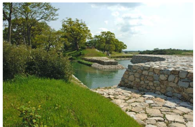
図-17：保全復元した象の鼻の野越
