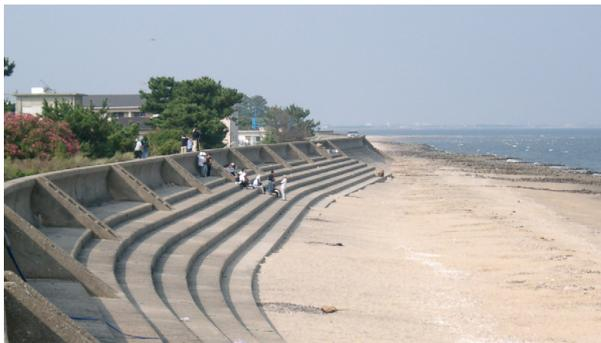
図-9 既設の階段式護岸
