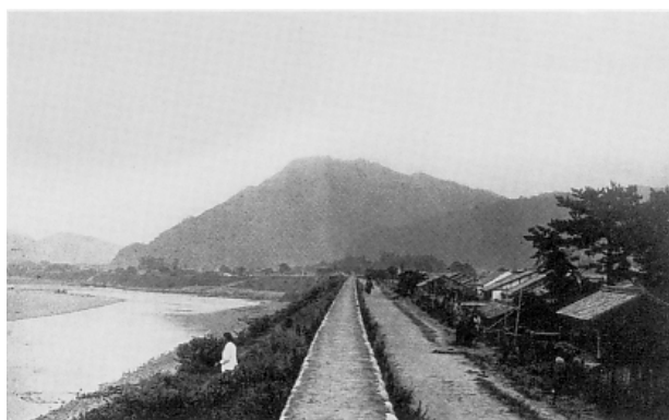
写真-1 特殊堤施工時の水辺（昭和初期）
