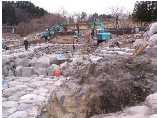
図一 10 現地施工状況
