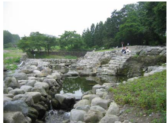
図一 13 完成状況
