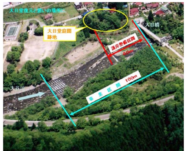
図-9 施工箇所状況写真
