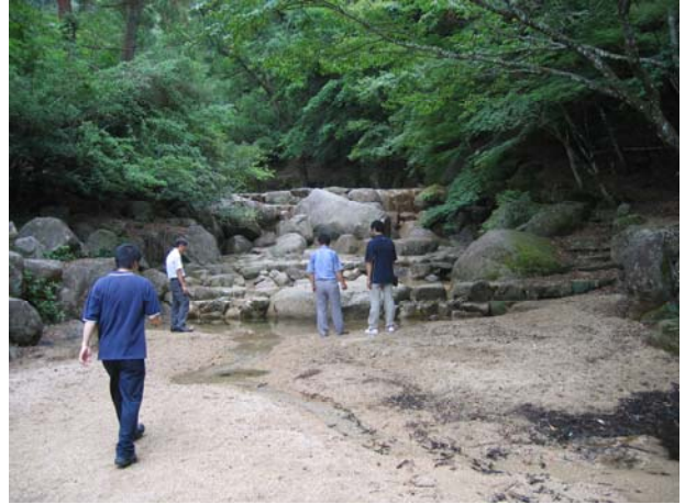
図-8 紅葉谷川庭園砂防
