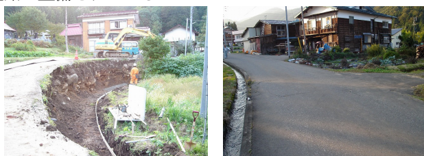
図-6 直営道路改良事業 左：工事風景 右：整備された村道
