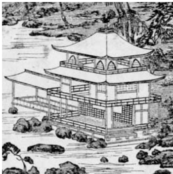
図-2 舍利殿の外観の様子
