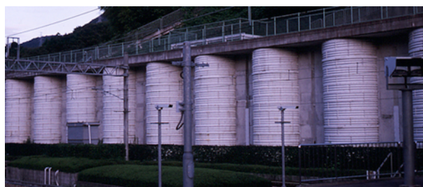
図-7 砂詰めコルゲート管による自立擁壁（神戸市）
