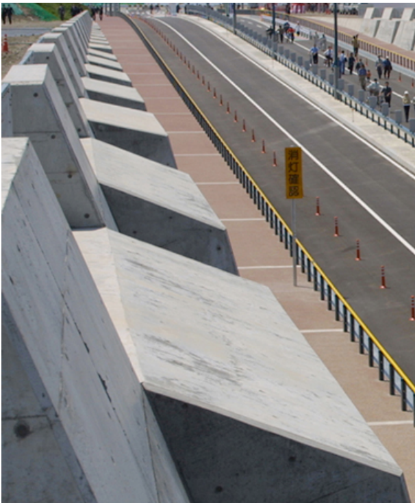
図-11 擁壁天端部(竣工写真。立体2の天端面の傾斜角の段階的な変化。写真手前から2つめまでと3つめ以降、さらに8つめ以降で異なっている。反対側の歩道上からの視認性を考慮)
