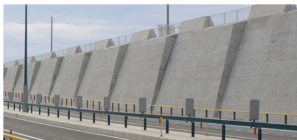
図-15 擁壁天端と転落防止柵(竣工写真、堀割道路上から)
