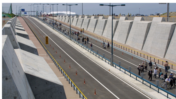
図-14 堀割道路部俯瞰(竣工写真、横断橋梁上から)
