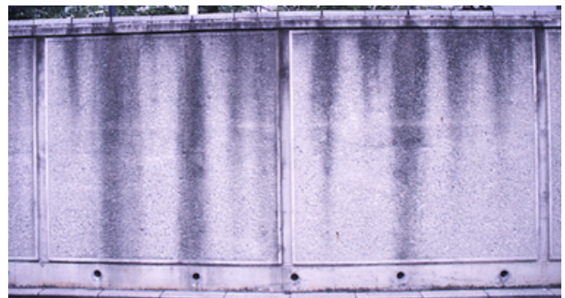
図-5 擁壁面の化粧目地による分節（東京都）
