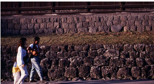
図-3 石垣の複断面構成（日光東照宮）
