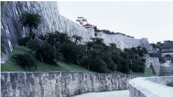
図-2 高石垣基部の腹付け（首里城）
