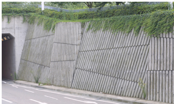
図-6 擁壁面の立体的造形（新潟市）
