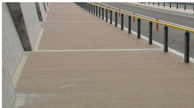
図-13 歩道部(竣工写真、擁壁との対比をねらい、舗装面を暖色系の骨材をもちいた洗出し仕上げとし、歩道上のガードフェンスのトップレールに華やかな色彩を採用した)
