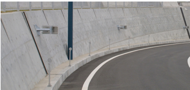
図-17 ランプ部擁壁(竣工写真。擁壁勾配を法尻から天端まで一定にした通常の断面と、天端付近だけをわずかに変えた断面の2パターンを用意して、現場対応で交互に反復させた)
