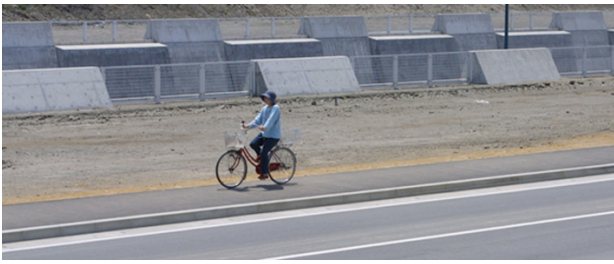
図-16 擁壁天端と転落防止柵(竣工写真。堀割道路外敷地から)
