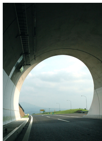
図-13 坑口からの風景
