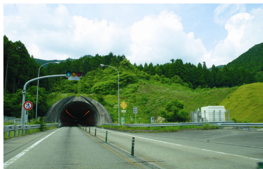
図-7 えびの側上り線の既存坑口
