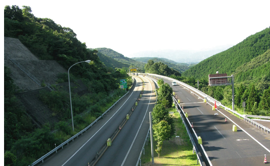
図-4 人吉側坑口からの風景
