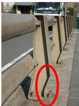
図-1 座屈を誘発するための切れ込みが特徴的な機能重視の防護柵
