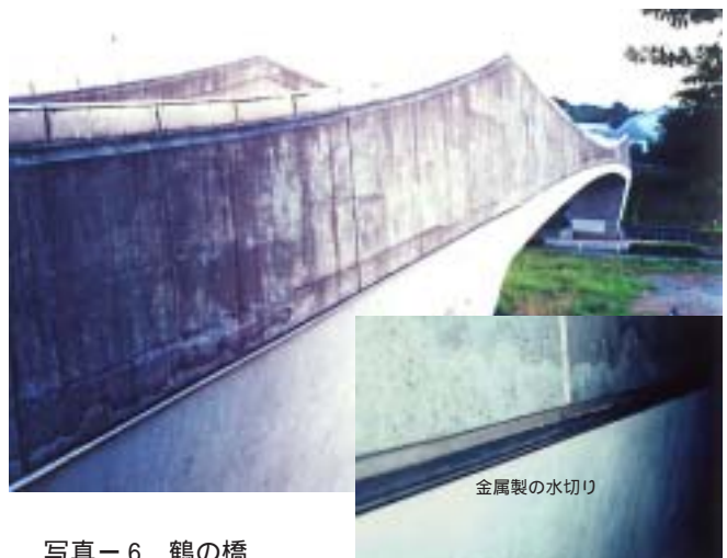
写真-6 鶴の橋 主桁の中間部分で、汚す、汚さないをコントロール
