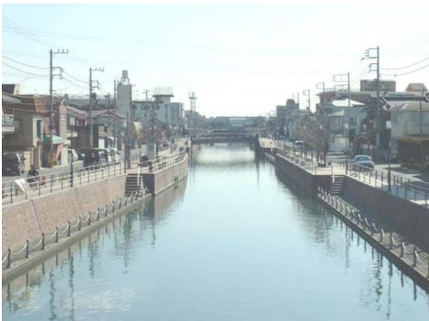
写真-5 整備後の境川（小段および透過性の高い手すりが設置され親水性の高い空間となっている）
