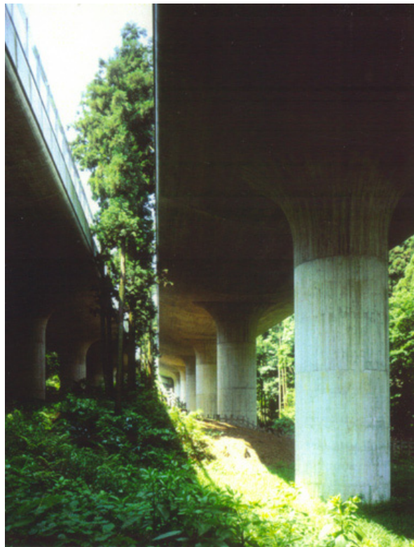
陣ヶ下高架橋
