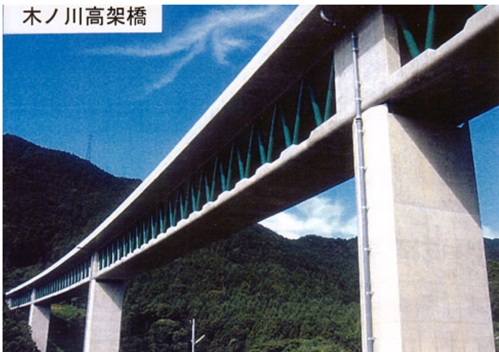
木ノ川高架橋
