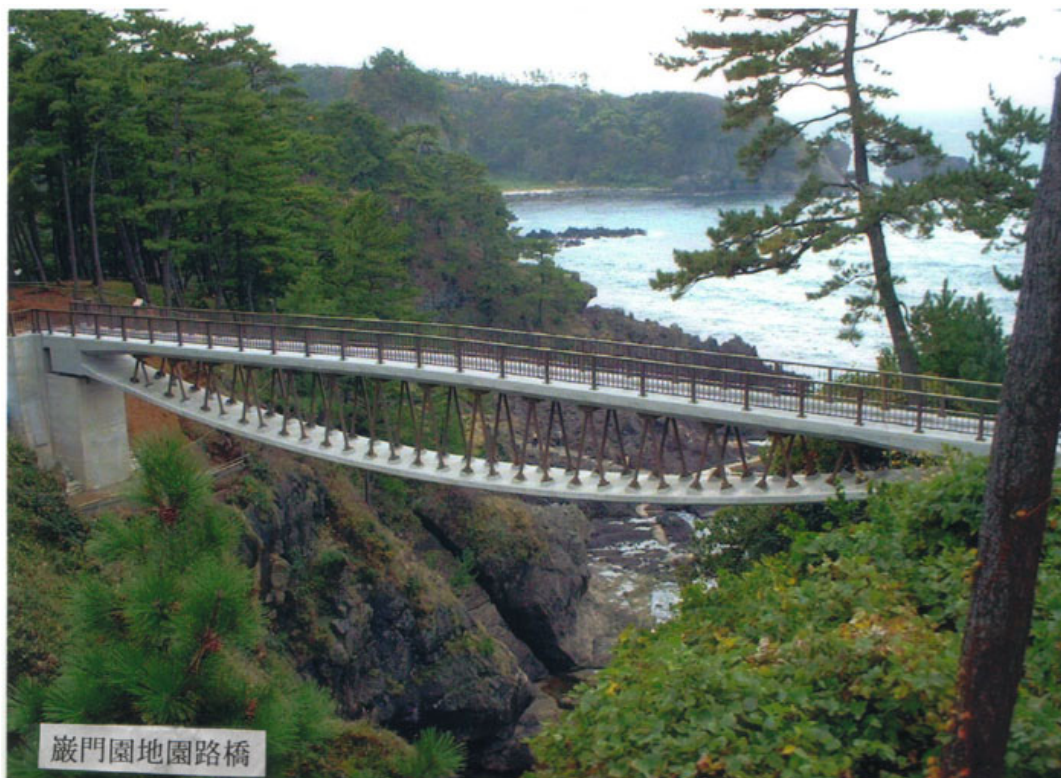
巖門園地園路橋
