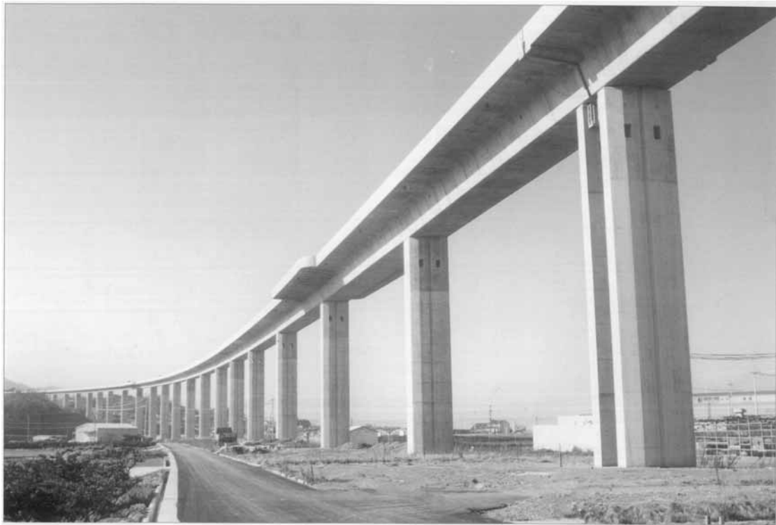
四国縦貫自動車道 重信高架橋
