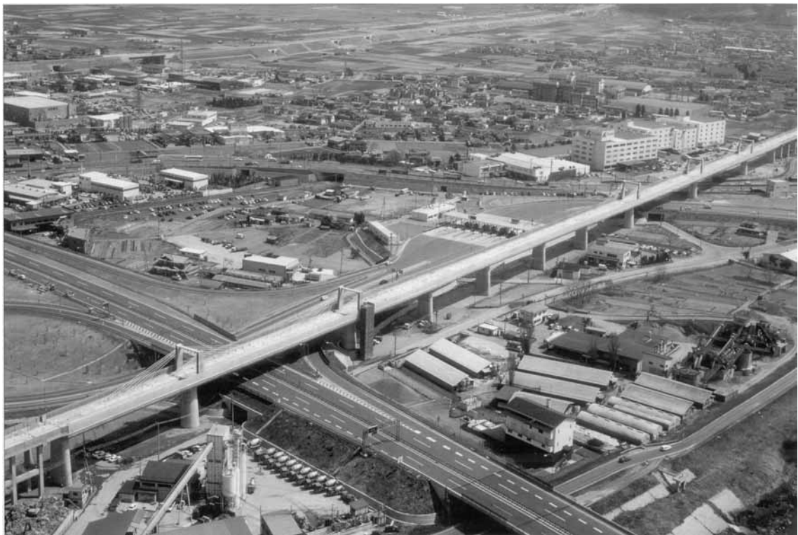
北陸新幹線 屋代橋りょう
