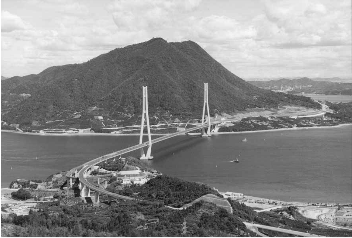
多々羅大橋
