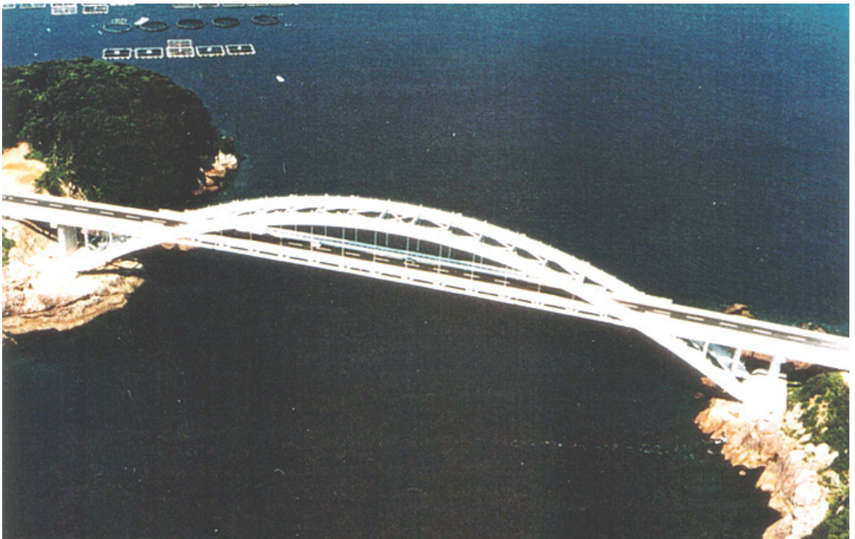
くしもと大橋
