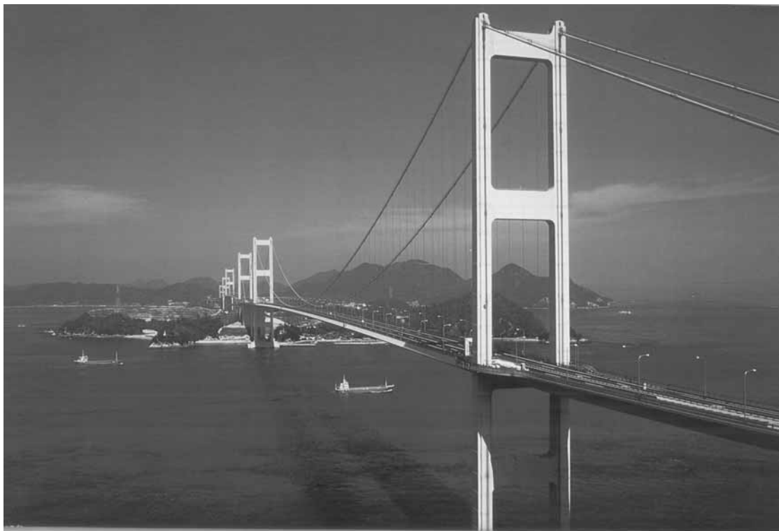
来島海峡大橋
