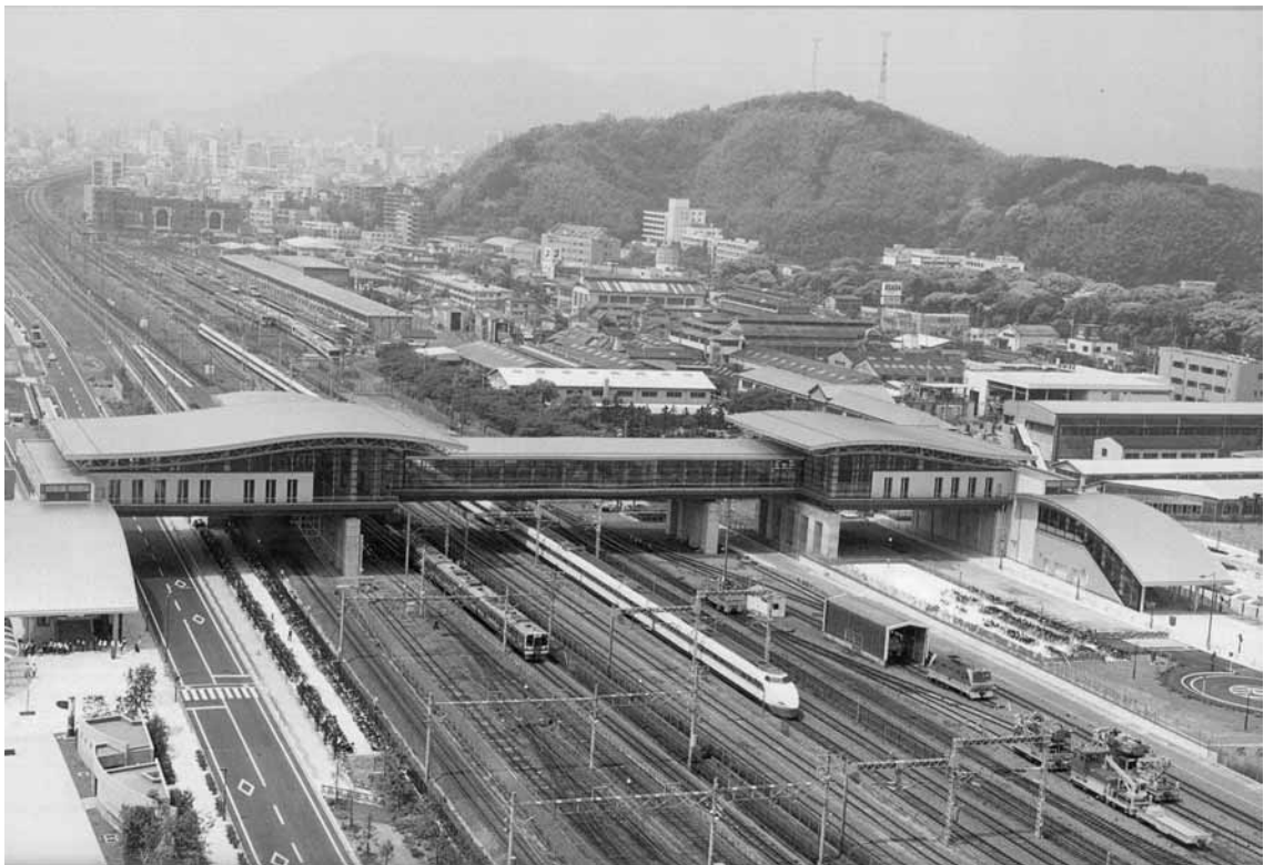
東静岡駅南北自由通路橋
