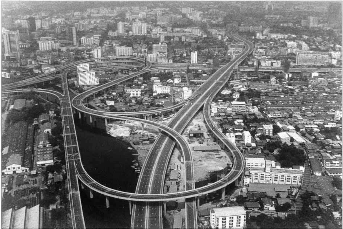
バンコク第2高速道路（第1期工区）
