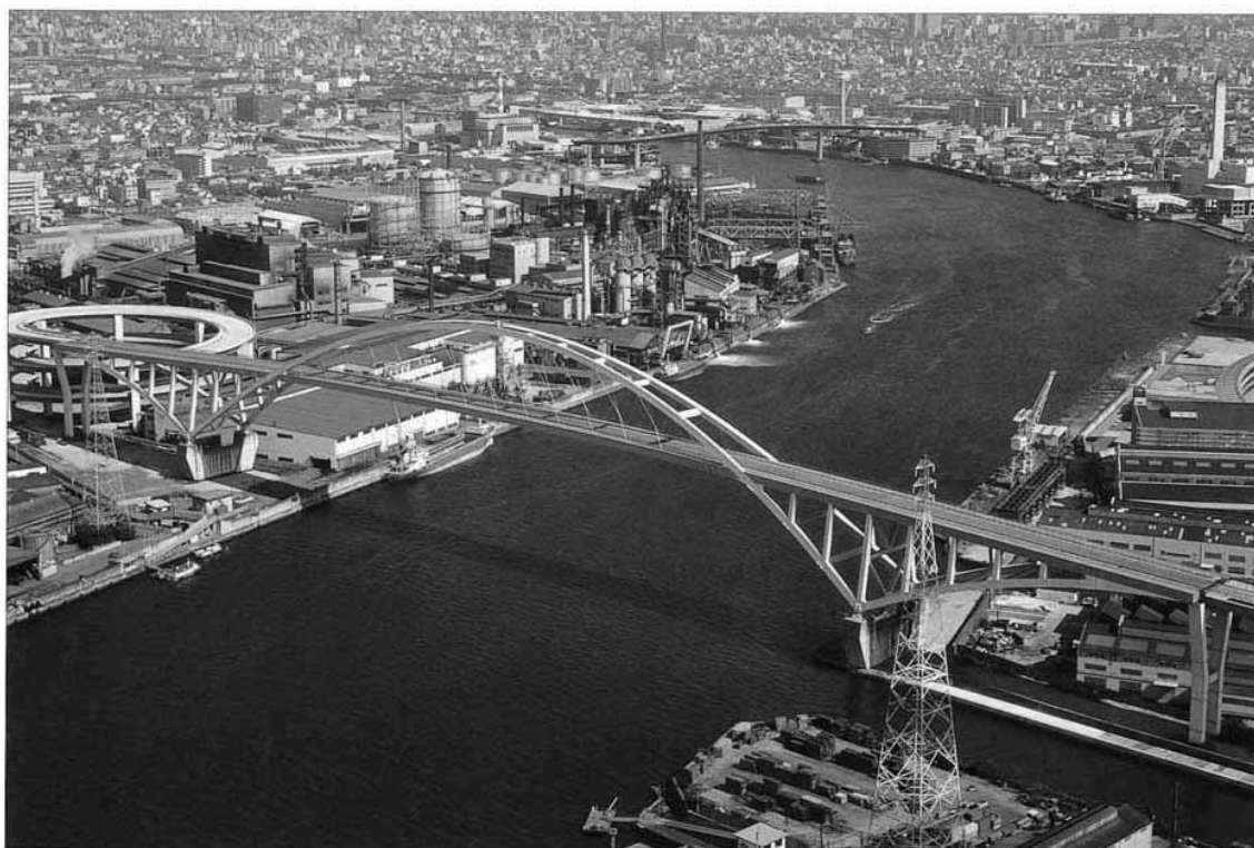
新木津川大橋
