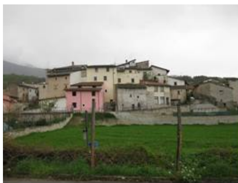
写真-82 城壁のような連結された住宅
