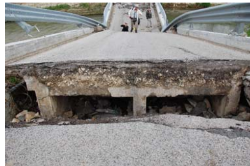
写真-132 桁断面
