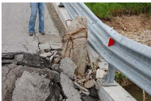
写真-135 床版上に突出した橋脚頭部
