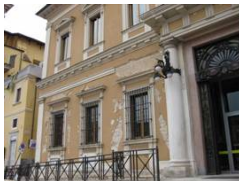
写真-25 広場の南西角のRC造建物
