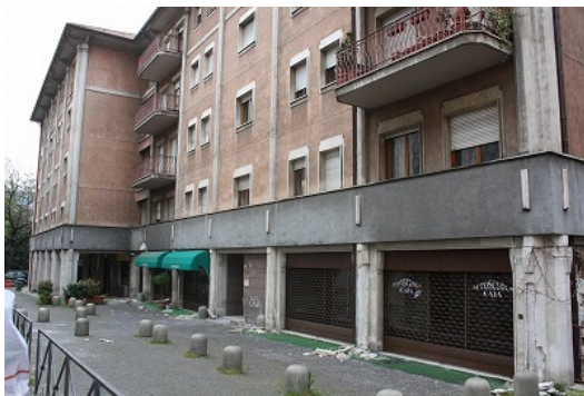
写真-53 EXP.Jで繋がるホテル 損傷小(9,10)
