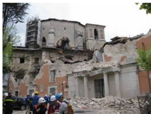
写真-35 組積造の 2 階部分が崩壊
