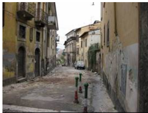
写真-29 Via Donadei通りの仕上剥落
