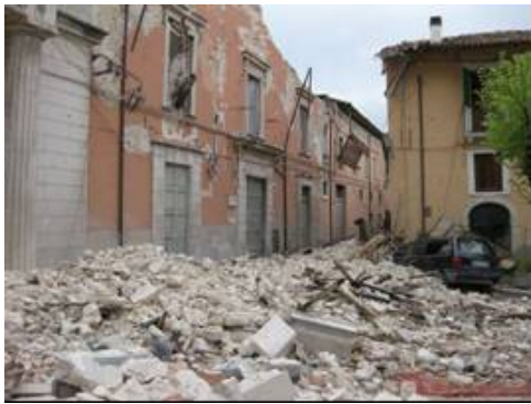
写真-36 落下した外壁により車が下敷
