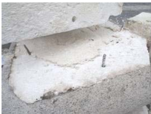
写真-22 ダボ筋による接合
