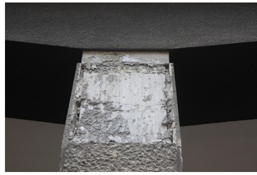
写真-40 ピロティ部柱頭の仕上げ材剥落(2)
