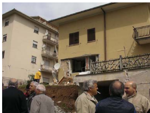
写真-120 盛土崩壊の様子
