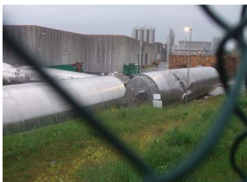
写真-164 バーナーで切断されたサイロ
