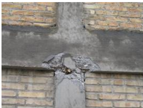
写真-97 柱頭部のひび割れ（非常に細いせん断補強筋）
