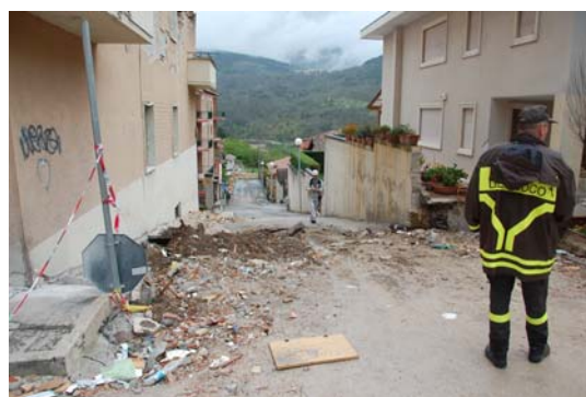
写真-11 応急的に埋め立てられた写真-10 と同一箇所（web による）
