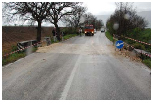
写真-145 石灰岩質の碎石投入により 応急復旧された路面
