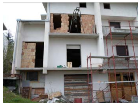
写真-105 強震計 FA030 そばの建設中の住宅
