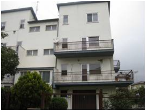
写真-91 4階建てRC住宅
