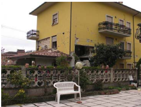
写真-109 平均的な RC 建物
