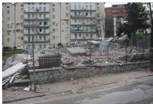
写真-55 倒壊した建物(1)
