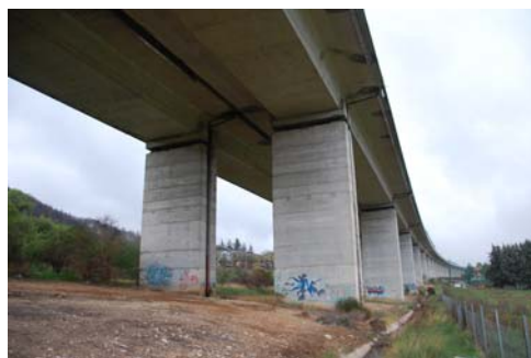
写真-150 A24 高架橋
