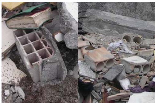
写真-56 空洞煉瓦(1)
