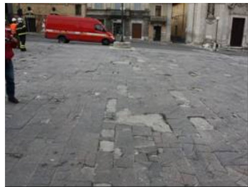
写真-17 石畳の損傷
