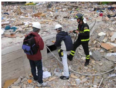
写真-58 シュミットハンマー調査／建物基礎部分にて(1)
