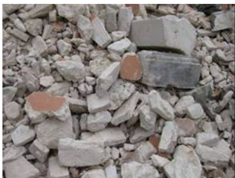
写真-32 崩壊した組積材と仕上の残骸
