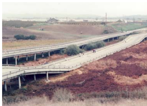
写真-138 ストラブスルー橋の被害 (1989 年ロマプリータ地震)
