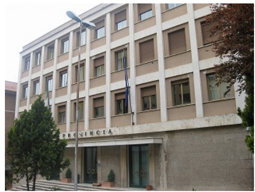
写真-54 行政関係の建物 損傷なし(11)
