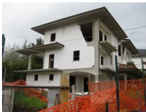
写真-78 RC住宅の組積壁せん断破壊と仕上剥落
