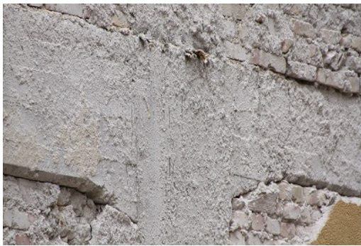
写真-49 接合部拡大：柱左右で梁せいが異なる(5)
