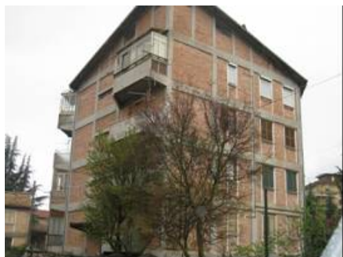
写真-99 4階建てRC造集合住宅
