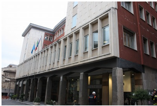
写真-39 1階部分がピロティ形式の建物(2)
