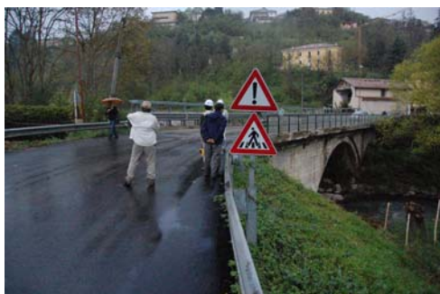
写真-147 石造アーチ橋取り付け盛土の沈下補修
