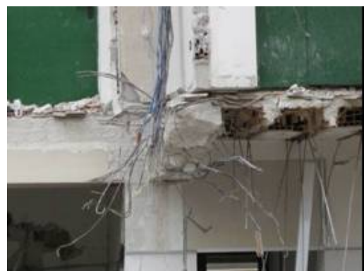
写真-71 2階梁とスラブ
