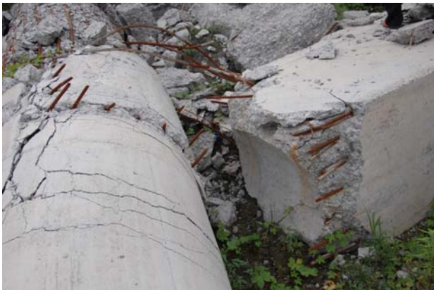
写真-18 橋脚と横梁接合部の分離 (P5橋脚)
