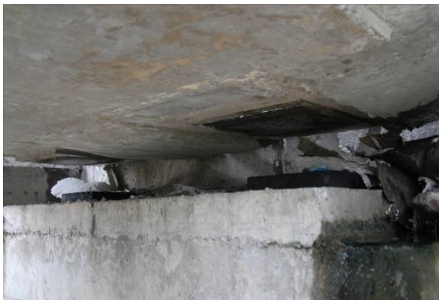
写真-38 A1 橋台部での桁の浮き上がり
