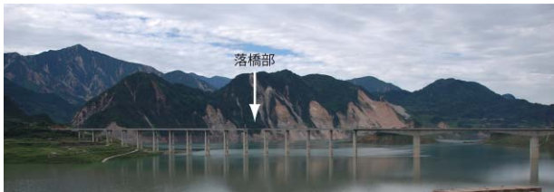
写真-1 廟子坪橋と落橋したスパン
