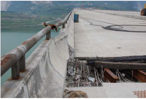
写真-5 連結桁間の橋軸直角方向の桁移動
