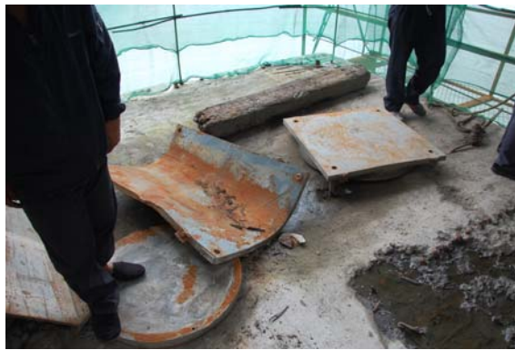
写真-11 撤去されたラーメン橋の端部を支持していた可動支承
