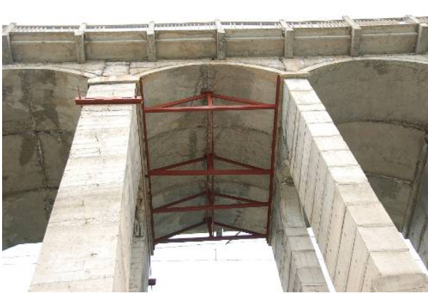
写真-44 アーチクラウン継ぎ目部の圧壊
