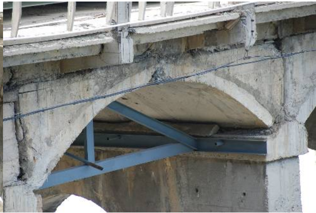
写真-45 アングル材でトラス状に応急補強された床版損傷部 (橋面上にはペレ桁で補強されている)
