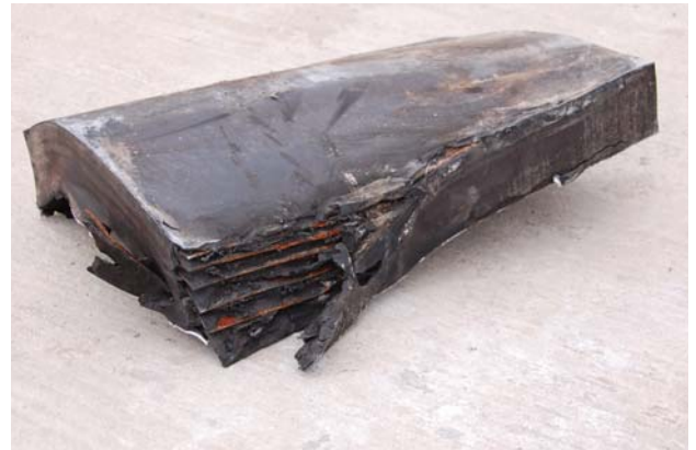
写真-8 損傷した積層ゴム支承 (T桁橋)
