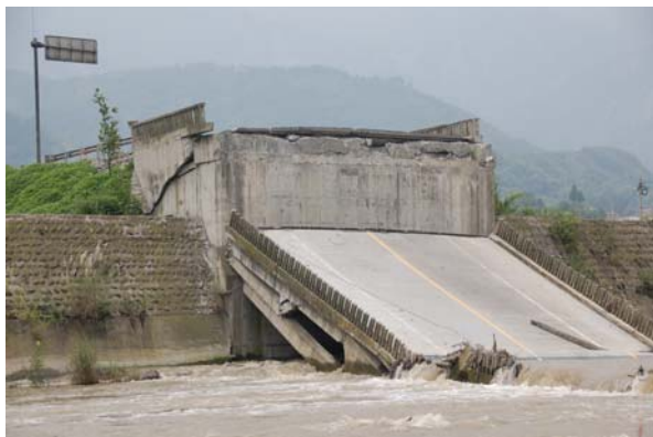
写真-24 A2橋台から落下した桁4 (桁が橋台に衝突し、橋台が裏込め側に押し込まれた結果、橋台側面の擁壁がせん断破壊している)
