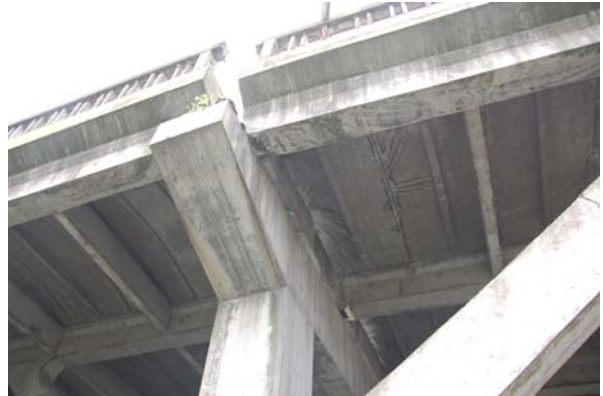
写真-23 P1橋脚上の桁2の支持状態
