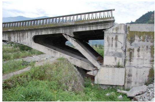
写真-21 A1部におけるラーメン脚及び斜材の被害
