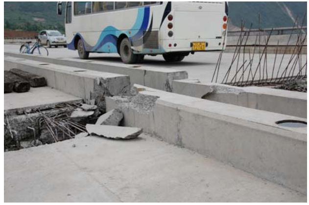
写真-6 連結桁間の衝突による損傷と上下方向の段差
