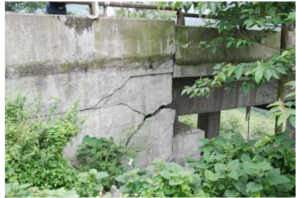
写真-33 主桁の衝突に伴う橋台の被害
