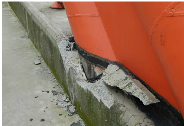
写真-56 パイプアーチ位置における縁石の損傷
