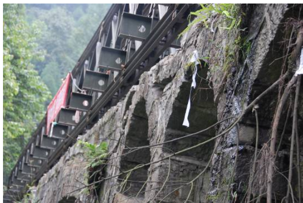
写真-50 アーチクラウンと1/4点との中間部に生じた損傷
