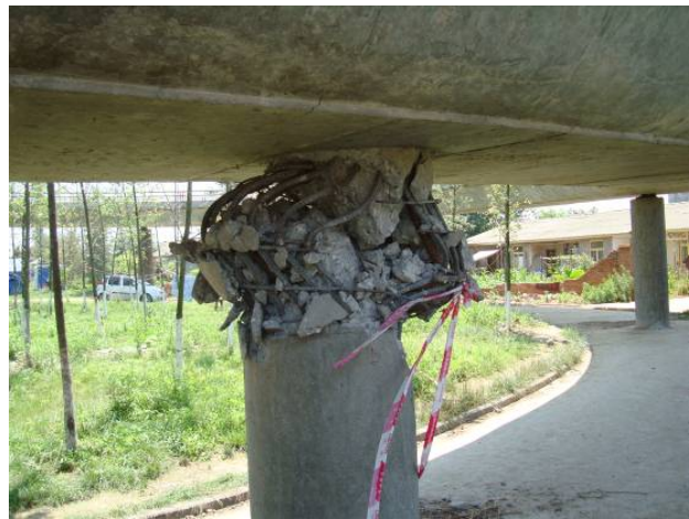
写真-37 P2 橋脚の被害と P3 橋脚
