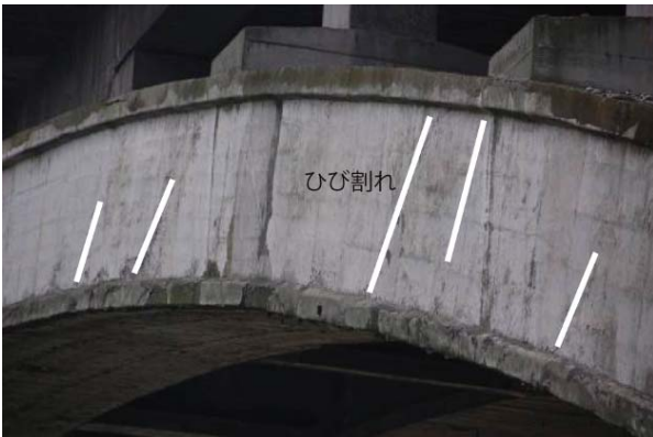
写真-34 アーチクラウン部近くのひび割れ
