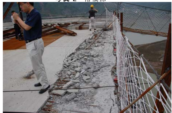
写真-4 引きずられて桁が落下した側の床版の損傷
