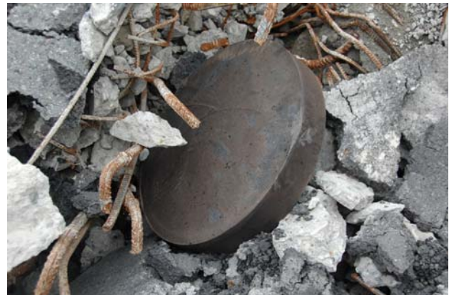
写真-14 落下したゴム支承
