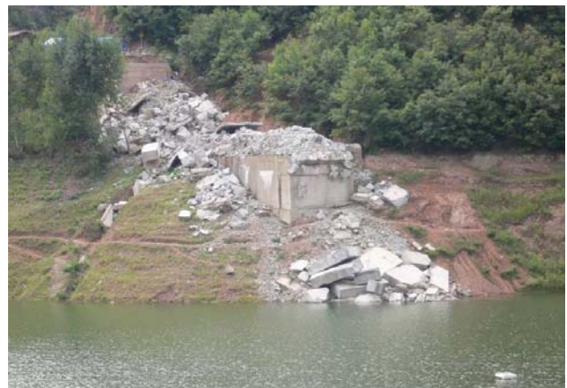
写真-41 左岸側のアーチリブ基部の破壊
