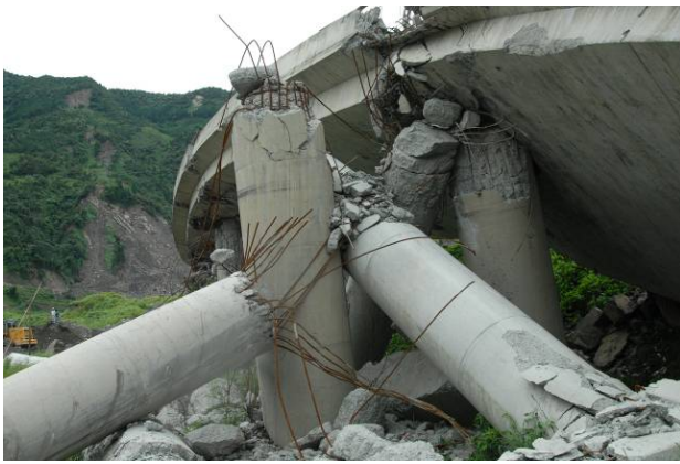
写真-17 落橋部の橋脚損傷状況 (P5橋脚)
