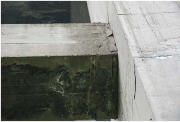
写真-32 鉛直材と横梁との接合部のクラック
