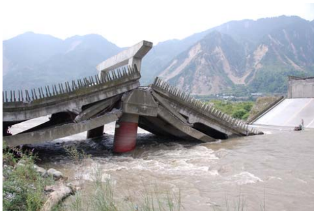
写真-26 A2側に傾斜したP3橋脚とこの頂部から落下した桁3及び桁4 (右手はA2)
