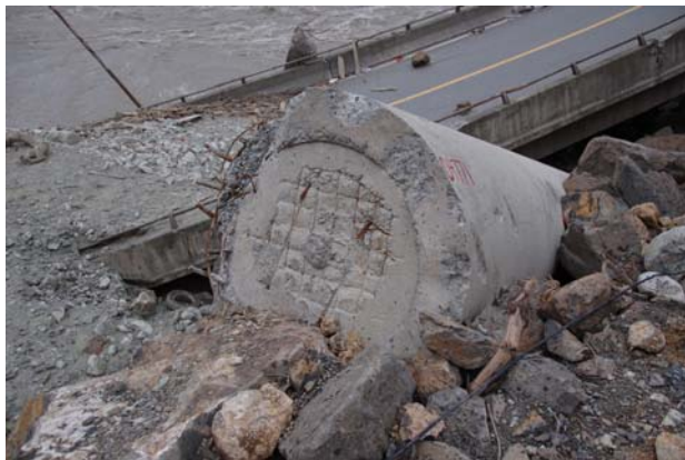
写真-15 ゴム支承が設置されていた橋脚柱上端
