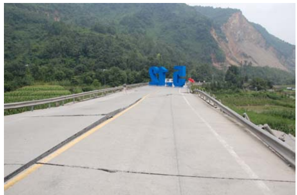
写真-27 左岸の上流側堤防 (点A, 小魚洞橋から約70m) に生じた段差
