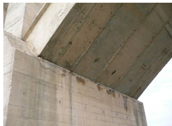
写真-43 アーチリブの付け根のひび割れ（圧壊）
