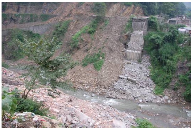
写真-46 倒壊した紅東大橋
