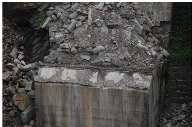
写真-47 アーチ主構の支持部
