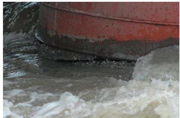
写真-25 パイルキャップ下の川面位置に生じた杭の曲げクラック (P3, 下流側)
