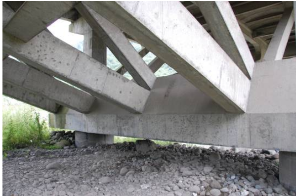
写真-22 P1橋脚におけるパイルキャップ構造
