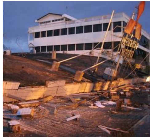
(d) Mitsubishi showroom
