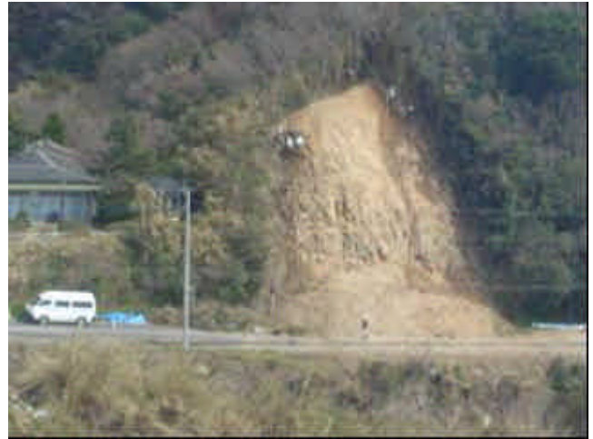
写真 13.22 島西側の斜面崩壊現場による復旧作業
