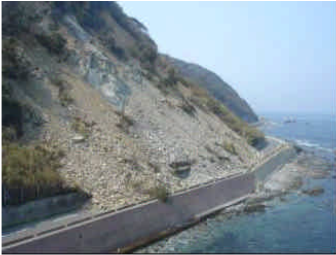
写真 13.21 大規模斜面崩壊による道路閉塞
