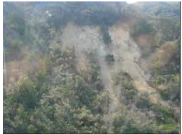
写真 13.24 島北東部の斜面崩壊
