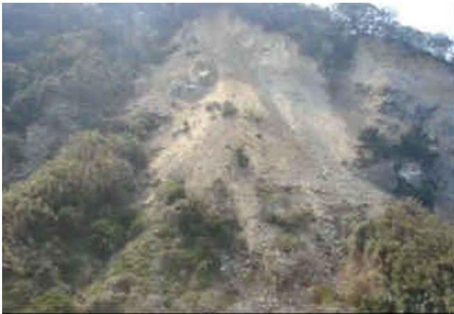
写真 13.23 島東部の斜面崩壊
