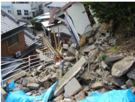
写真 12.2.10 宅地崩壊と道路の閉塞
