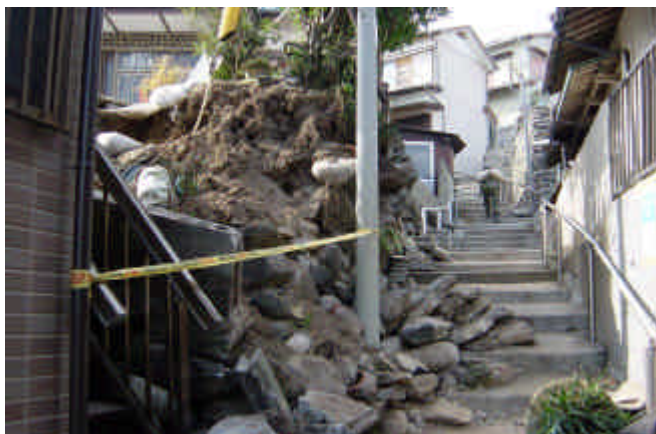
写真 12.2.3 崩壊石積みと土砂の道路への流出
