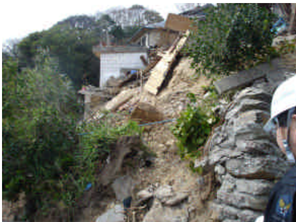
写真 12.2.12 擁壁の崩壊による宅地流出
