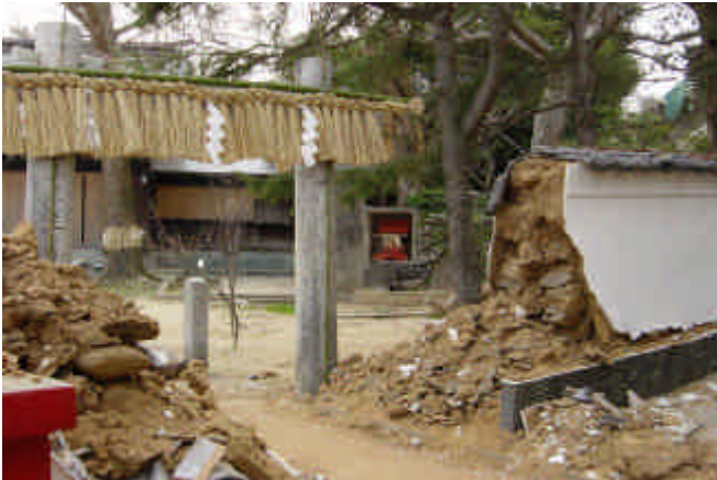
写真 12.2.24 小鷹神社の白壁の崩壊
