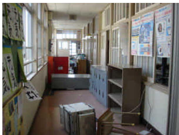
写真 12.2.17 玄海小学校の校舎内の状況
