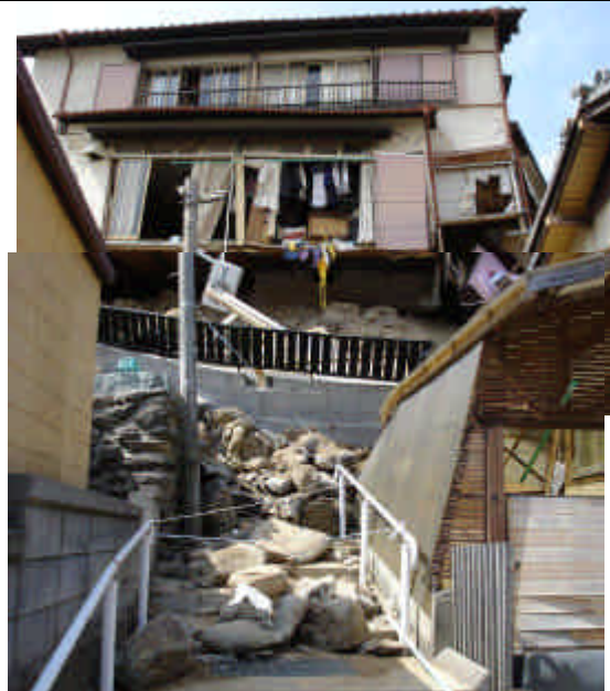
写真 12.2.9 擁壁・盛土の崩壊と家屋被災
