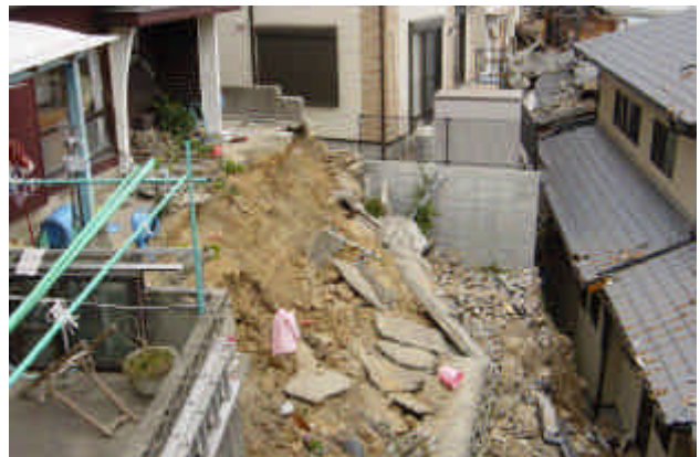
写真 12.2.9 擁壁・盛土の崩壊と家屋被災
