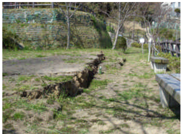
写真 12.2.29 展望台公園の亀裂
