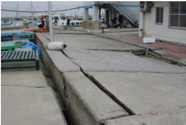
写真 12.2.6 岸壁の沈下
