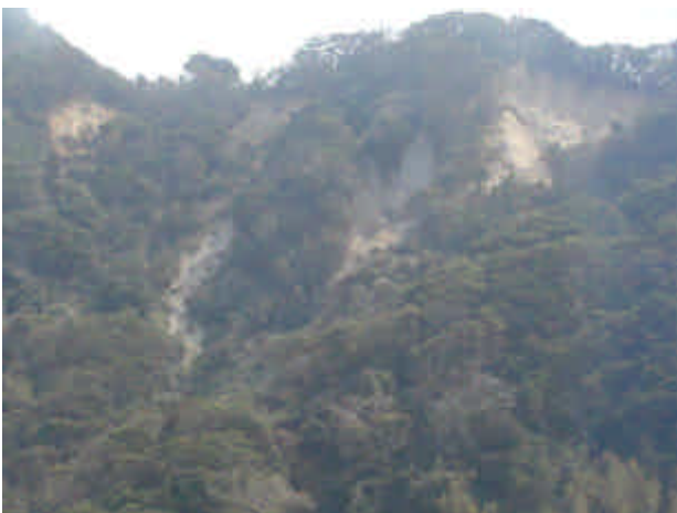
写真 12.2.28 島北東部の斜面崩壊（空撮）
