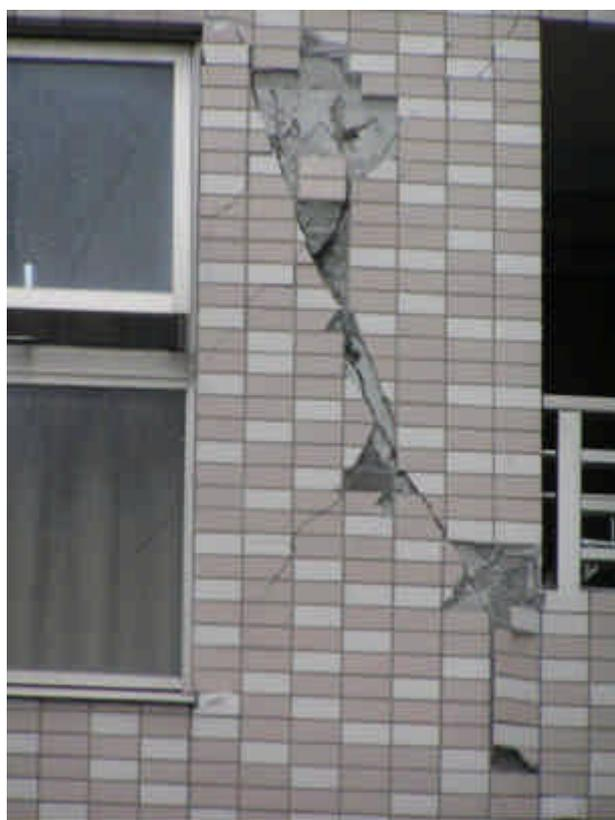
写真 - 3 柱の損傷
