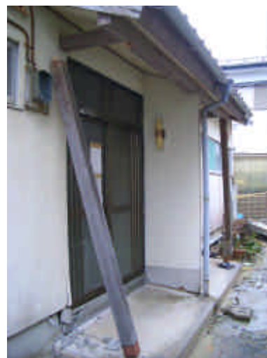
図-10.3.6 玄関の柱が脱落 玄界島
