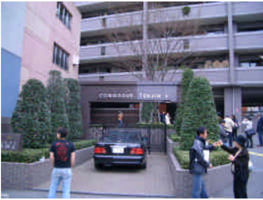
図-10.2.1 被害の大きかった今泉 2 丁目のマンション
