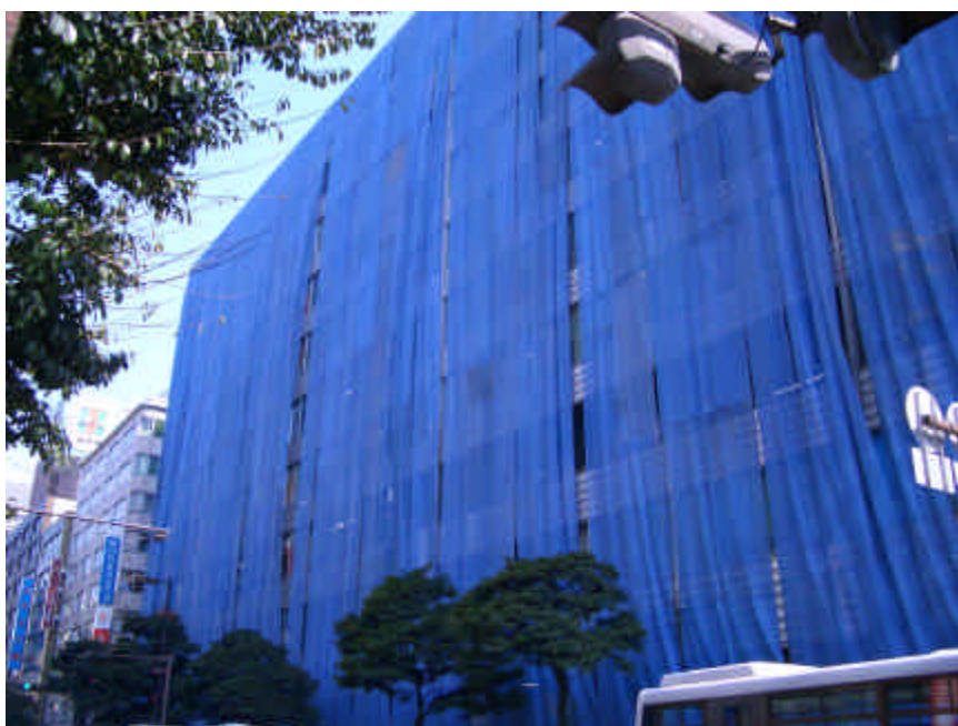
図-10.7.2 二次災害対策後の状況
