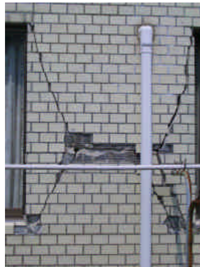
図-10.4.16 外壁のせん断亀裂 宮浦
