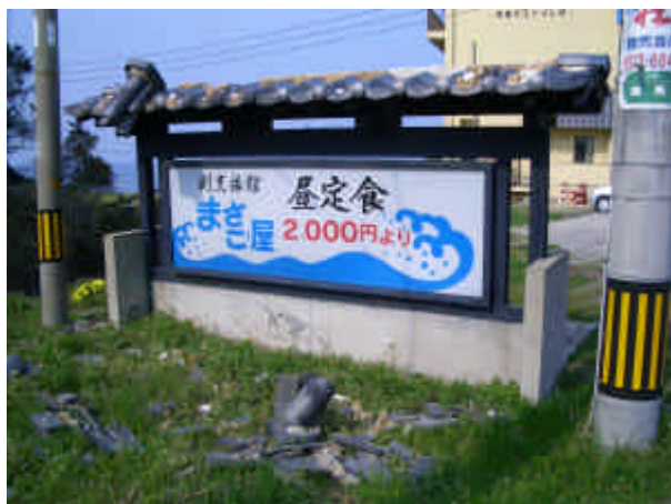
図-10.5.9 屋根が損傷した看板 勝馬
