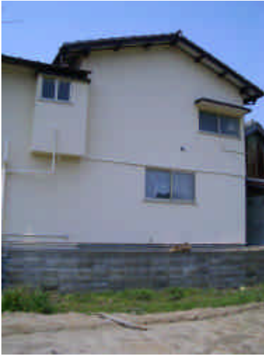
図-10.4.13 接合部に生じた鉛直方向の亀裂 宮浦
