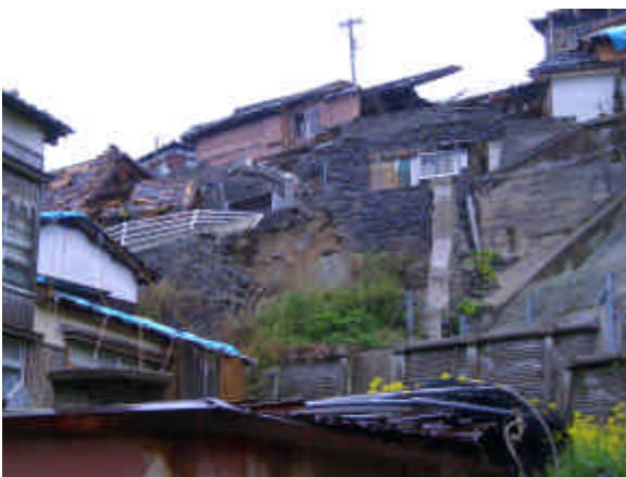
図-10.3.17 擁壁の崩壊を伴う住宅被害 玄界島
