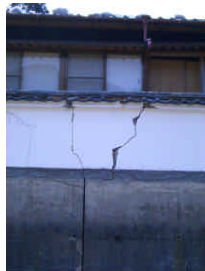
図-10.4.10 白壁の塀に入った亀裂 宮浦
