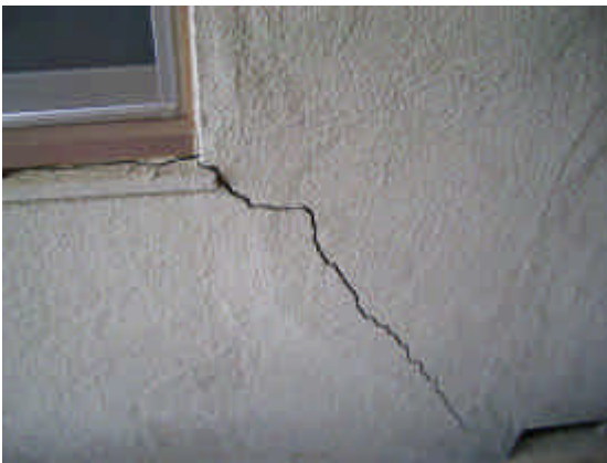
図-10.3.3 玄界中学校 窓枠コーナーの亀裂
