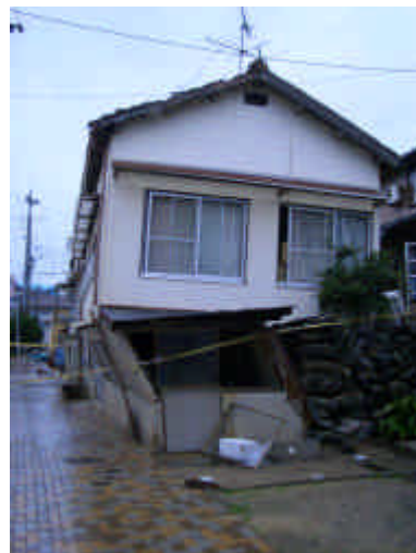
図-10.3.16 1階が倒壊寸前の住宅 玄界島
