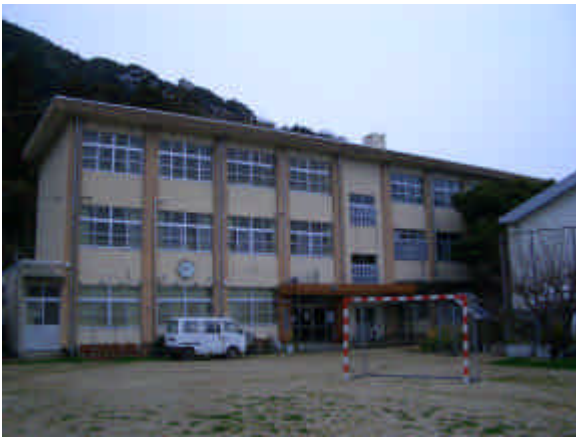
図-10.3.1 玄界中学校 外見上は大きな損傷は認められない
