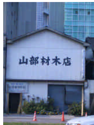
図-10.2.6 倒壊の恐れがあるため周辺まで避難勧告が出された材木店
