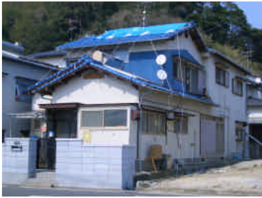
図-10.5.1 木造住宅の屋根の被害 弘
