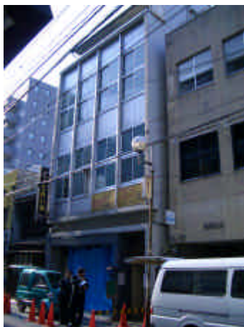
図-10.2.5 倒壊の恐れがあるため周辺まで避難勧告が出されたビル
