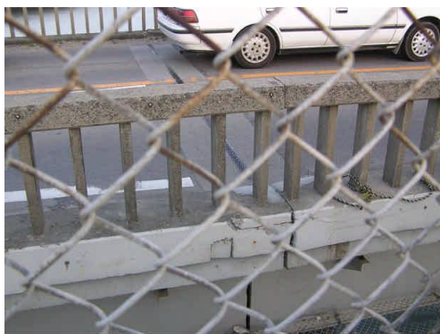
(a) 周辺地盤の沈下による橋台のズレ
