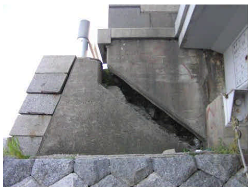
(a) 周辺地盤の沈下による橋台のズレ
