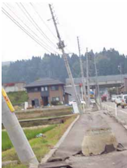
図9.4.9 電柱の傾斜（(財)電力中央研究所 井上研究 参事提供）
