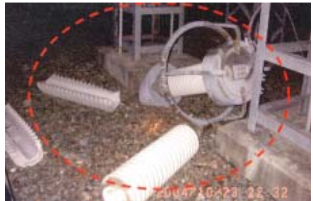
図9.4.7 避雷器碍管部折損（N変電所）
