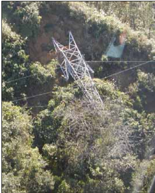
図9.4.3 倒壊した鉄塔 5)
