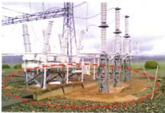
図9.4.6 遮断器，避雷器の基礎沈下（K変電所）
