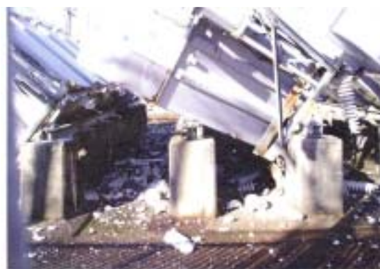
図9.4.8 電力用コンデンサの倒壊（N変電所）
