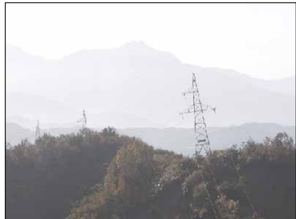
図9.4.4 傾斜した鉄塔 5)
