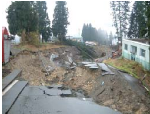
写真 9.2.1 地滑りにより流出した塩殿浄水場(小千谷市)
