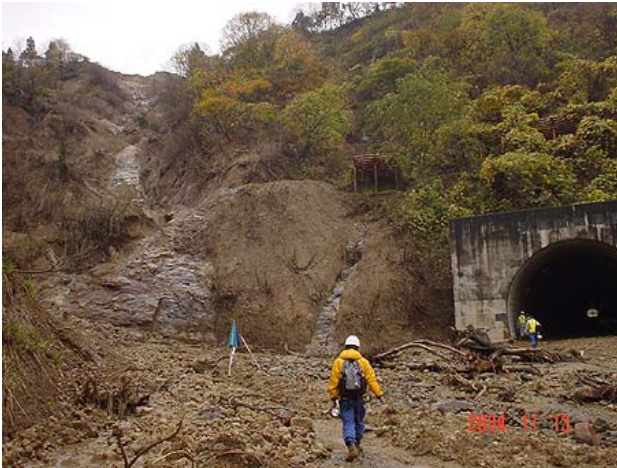
図 7.21 塩谷トンネル北西坑口あたりの土石流痕跡
