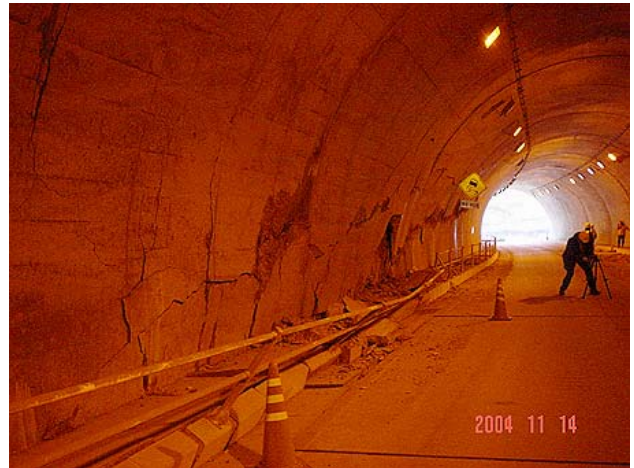
(a) 北側坑口に向かったの撮影
