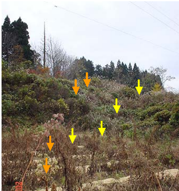
図7.12 図7.11の谷地形の上部：黄矢印の位置は旧滑り土塊の上端（推定）。手前畑地に亀裂の開口（橙矢印）。
