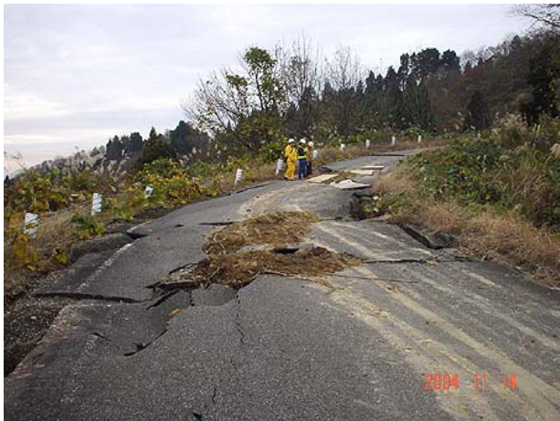
図7.13 木沢集落の北側、旧地すべり滑落崖上の状況：図7.10のBの亀裂
