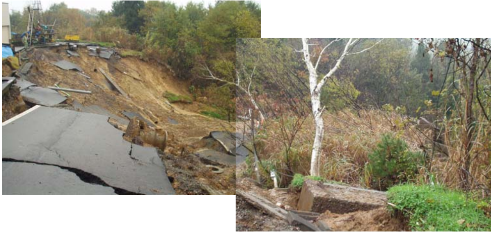
図6.2.5 高町団地・崩壊地点B
