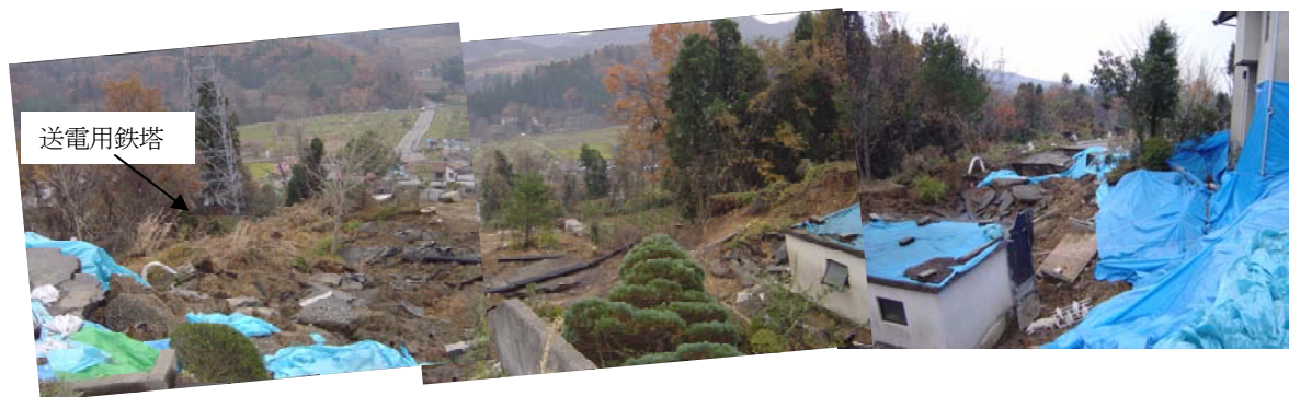
図6.2.9 高町団地・崩壊地点E
