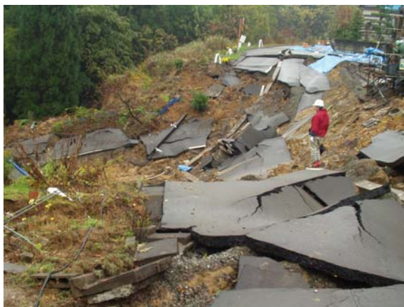
図6.2.6 崩壊地点Cの破壊状況
