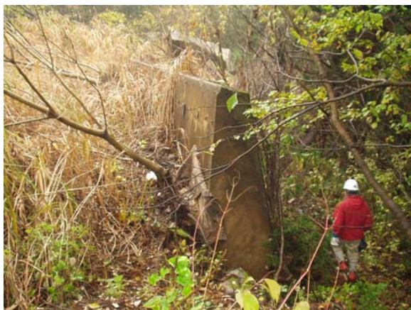
図6.2.7 崩壊地点Cでのもたれ式擁壁の移動
