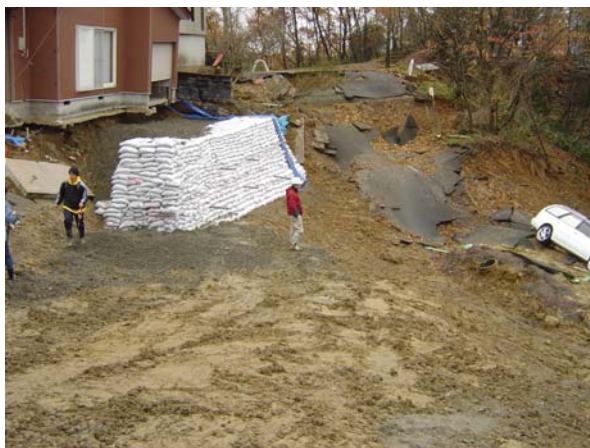
図6.2.3 高町団地・斜面崩壊 A の上部滑落崖
