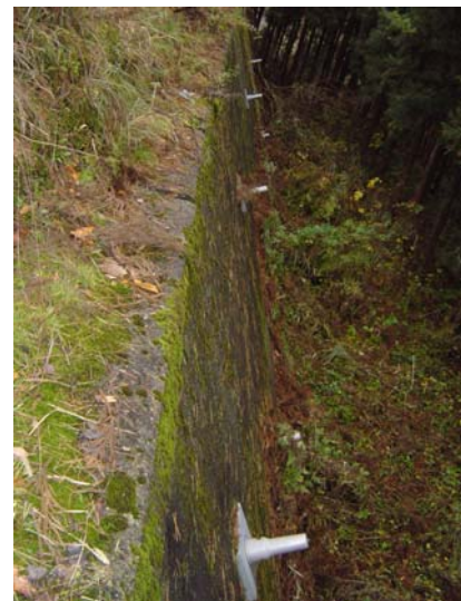
図6.2.8 もたれ式擁壁：アンカーと思われる補強が行われている。
