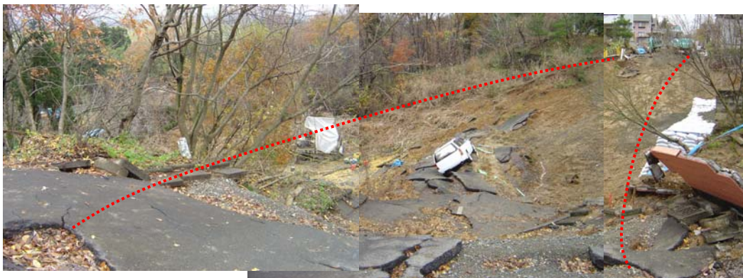
図6.2.2 高町団地・斜面崩壊 A
