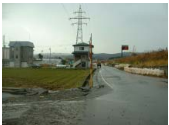
写真 6.1.3 法尻と側道のはらみだし
