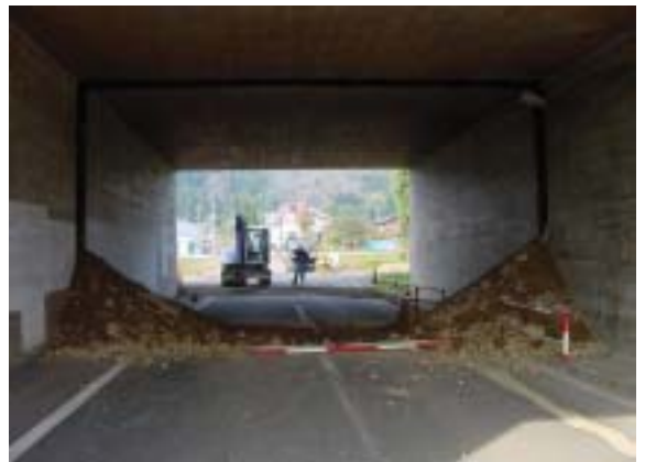
写真 6.1.2 カルバートの開きと落下した土砂
