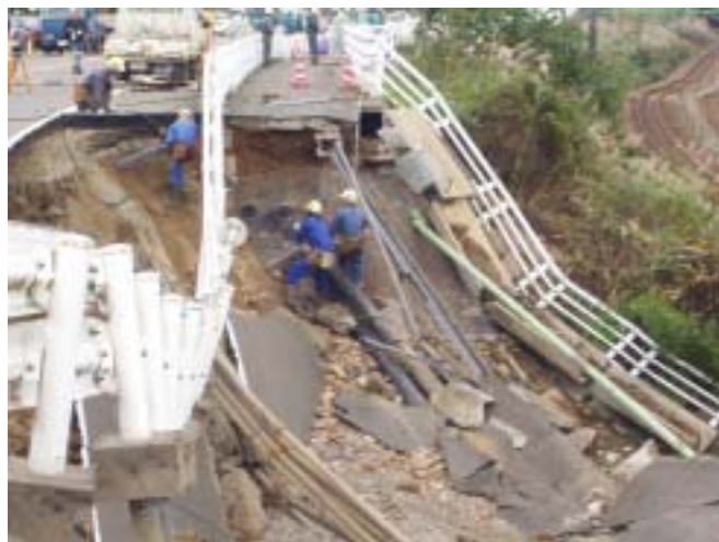
写真 6.1.6 天納地区における道路の崩壊に伴う埋設管の被害
