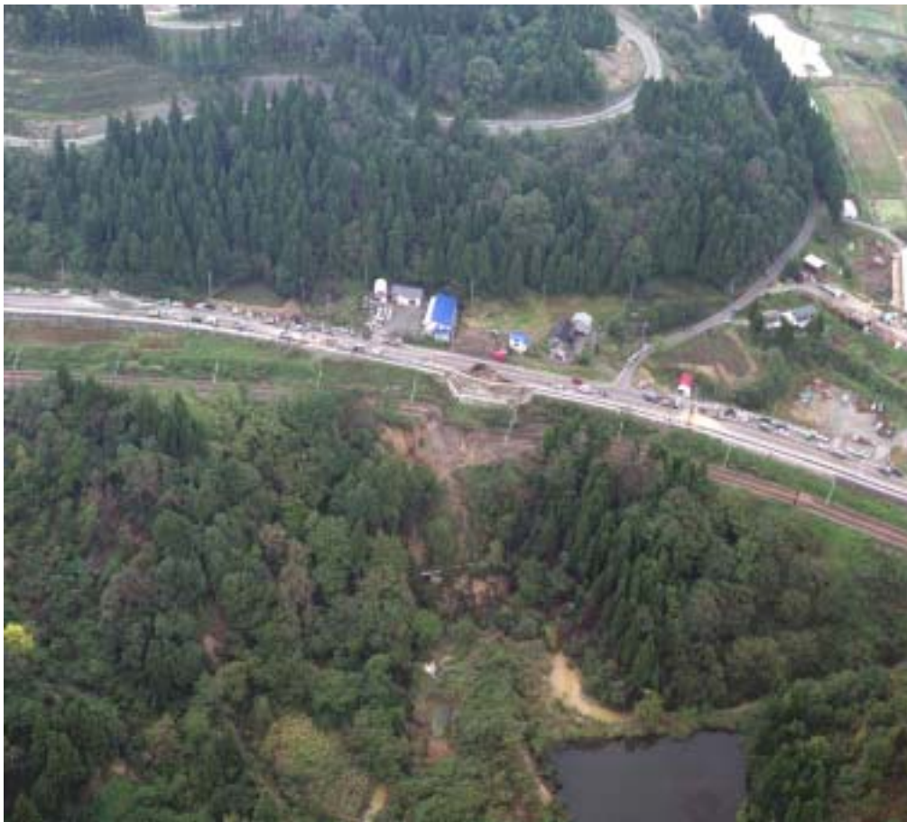
写真 6.1.5 天納地区における道路と鉄道の被害(株八州による撮影)
