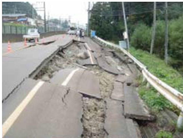
写真 6.1.4 稗生地区の道路盛土の崩壊
