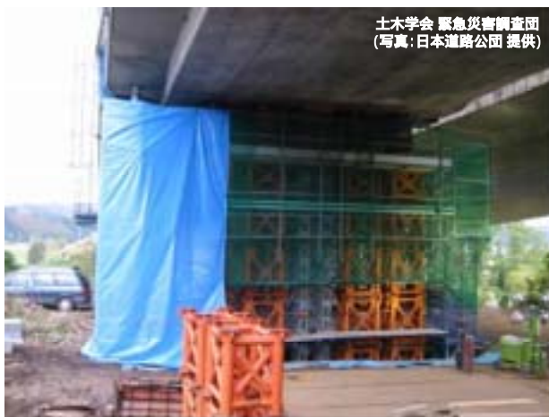
写真-5.2.12 P3 橋脚の復旧作業
