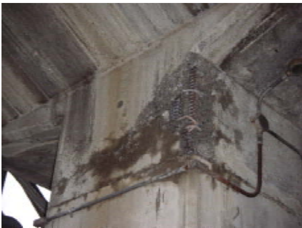
写真-5.1.7 第三和南津 R1 高架橋の損傷部
