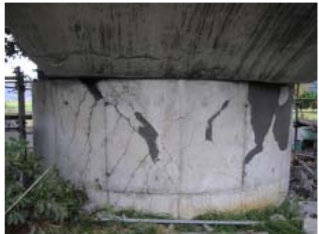
写真-5.2.5 橋軸方向面の斜めひび割れ
