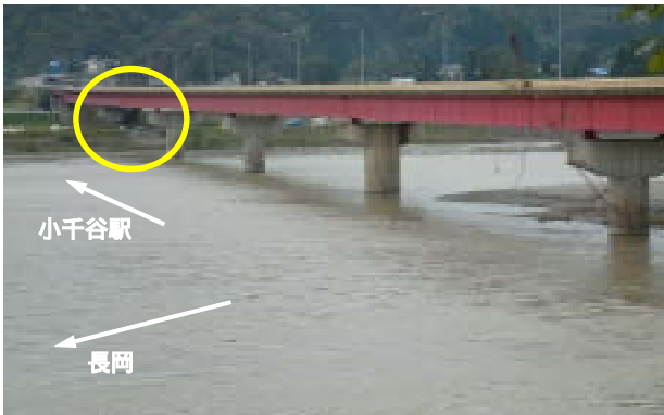
写真-5.2.1 小千谷大橋全景
