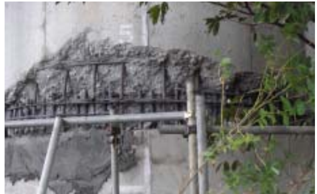
写真-5.2.4 P2固定支承橋脚の被害状況
