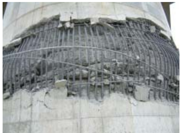
(a) 段落とし部の損傷状態
