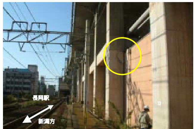
写真-5.1.17 第一袋町 R2 高架橋
