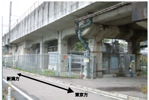
写真-5.1.6 第三和南津 R1 高架橋
