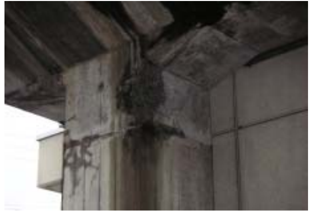
写真-5.1.5 第二和南津 R2 高架橋の損傷部
