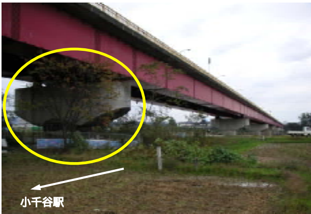
写真-5.2.2 P2固定支承橋脚
