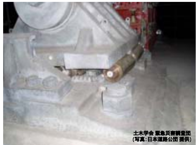
写真-5.2.9 P2橋脚支承部の損傷
