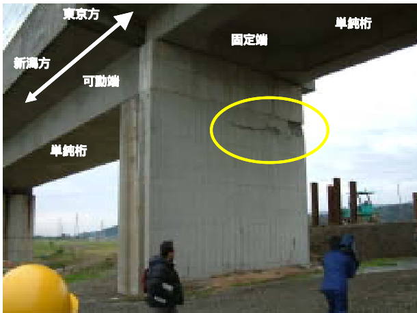
写真-5.1.15 東大新江橋梁
