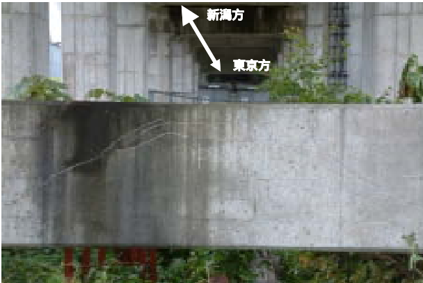
写真-5.1.4 第一和南津 R5 高架橋の損傷部
