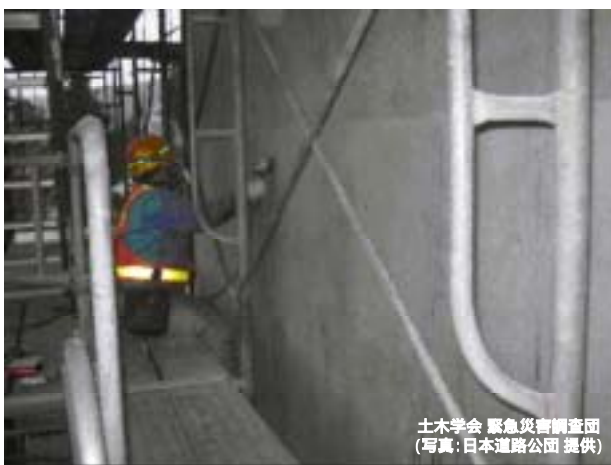
写真-5.2.8 P1橋脚復旧作業
