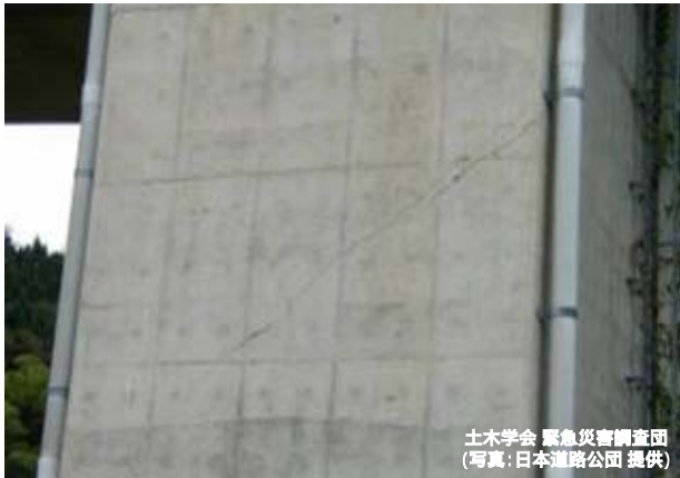
写真-5.2.7 P1橋脚のひび割れ状況
