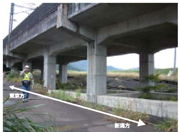
写真-5.1.3 第一和南津 R4 高架橋
