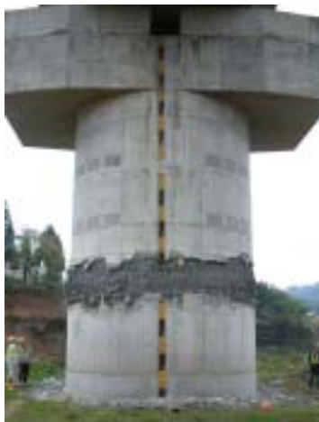
写真-5.1.9 魚野川橋梁 (3P 橋脚北面)
