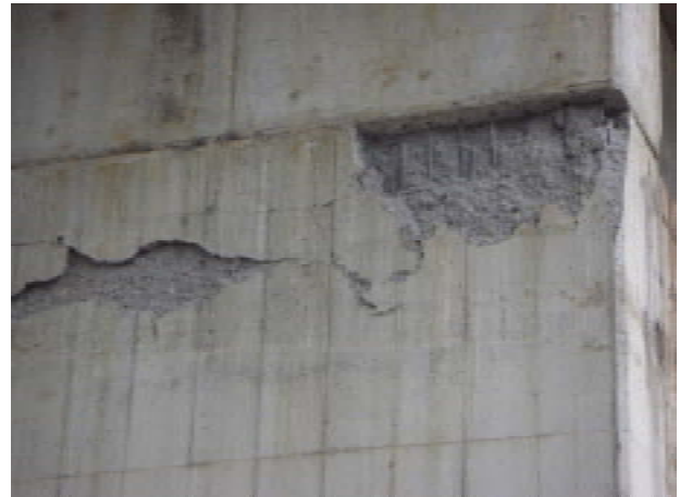
写真-5.1.16 かぶりコンクリートの剥落
