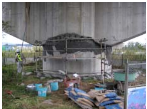
写真-5.2.6 P2固定支承橋脚の応急復旧作業
