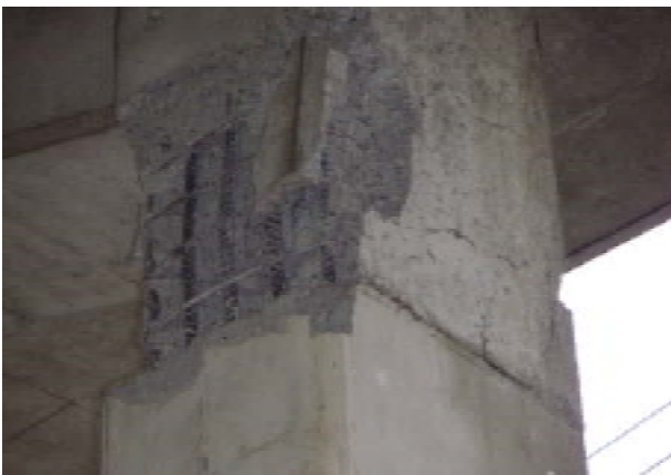
写真-5.1.13 村松 R6 高架橋
