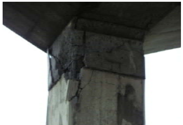
写真-5.1.14 村松 R7 高架橋
