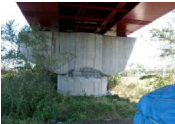
写真-5.2.3 P2固定支承橋脚の被害状況
