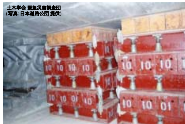
写真-5.2.10 P2橋脚支承部の応急復旧措置
