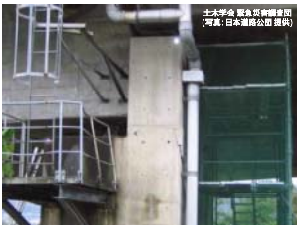
写真-5.2.11 P3 橋脚段違い部の損傷
