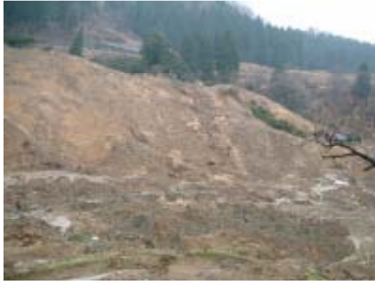
図-3.2.16 中流部での崩積土の崩落状態
