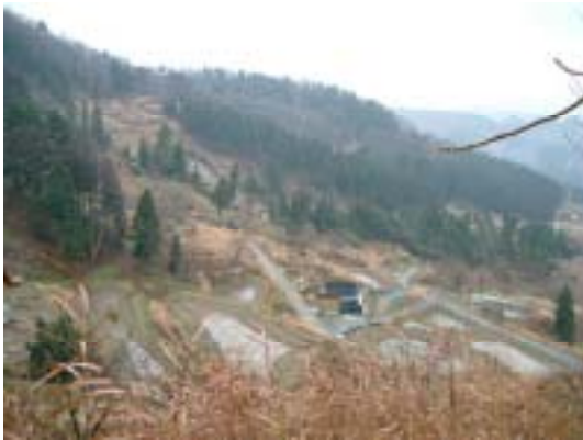
図-3.2.12 小栗山での崩壊斜面最上流部の崩壊で乱れている杉林の遠景
