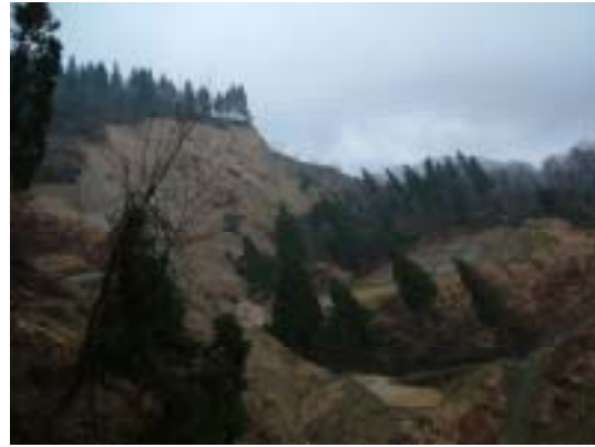
図-3.2.19 滑落崖と傾斜している移動山体の最上流部の遠景
