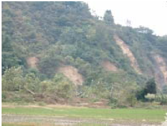
図-3.2.4 堀の内町 JR 北堀之内駅付近での横盤斜面の薄い滑り
