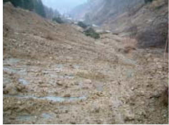
図-3.2.17 中流から谷の下流方向の遠望。連続した泥岩滑り面が見える。(E地点)
