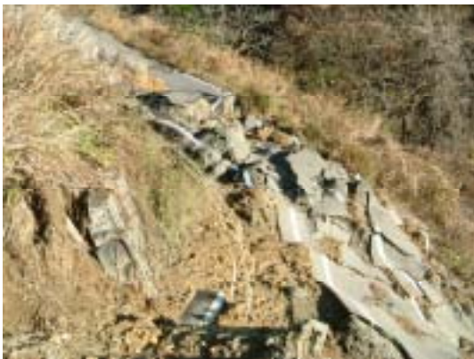
図-3.2.9 山古志村虫亀付近の池を巻き込んだ崩積土斜面の崩壊
