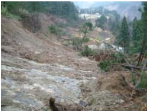
図-3.2.13 崩壊斜面最上流側から見た泥岩滑り面（A地点）
