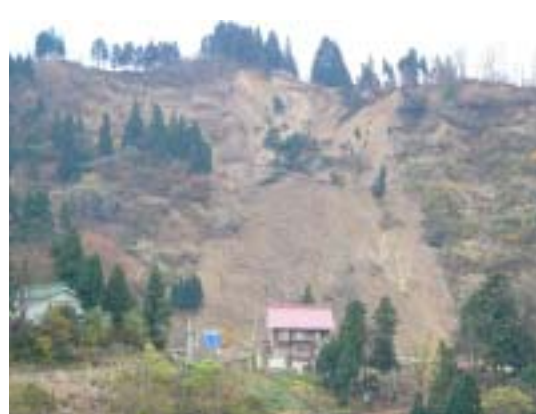
図-3.2.6 山古志村羽黒トンネル入口での受け盤斜面の崩壊
