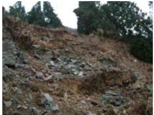
図-3.2.15 崩壊土の中に含まれている固結度の低い砂岩ブロック（C地点）
