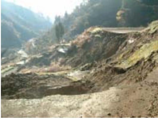
図-3.2.7 山古志村梶金付近での池を巻き込んだ崩積土斜面崩壊
