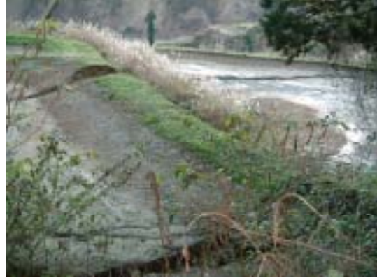
図-3.2.8 崩積土の崩落に路床ごと巻き込まれた梶金付近の国道 291 号
