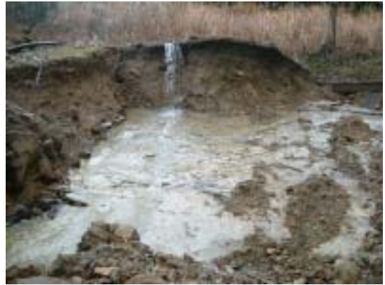
図-3.2.14 最上流部付近の小崩壊での泥岩滑り面（B地点）
