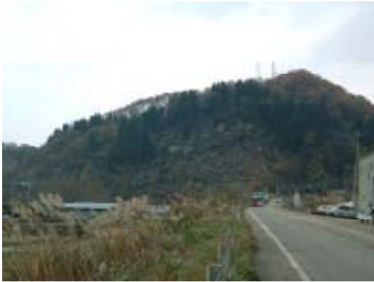
図-3.2.2 信濃川沿いの河川侵食の影響を受けた妙見白岩での流れ盤斜面滑り
