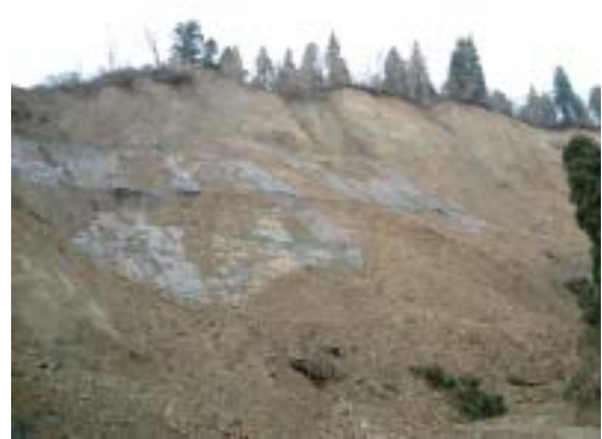
図-3.2.21 高さ 70m 、傾斜 36^\circ ほどの滑落崖に はほぼ水平な層理面が表れ、湧水が見られる
