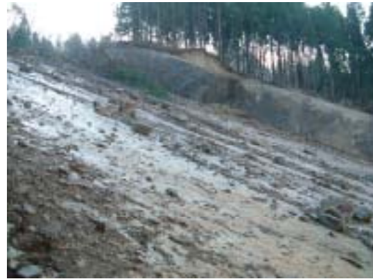
図-3.2.1 小千谷市浦柄付近での泥岩層理面での流れ盤斜面滑り
