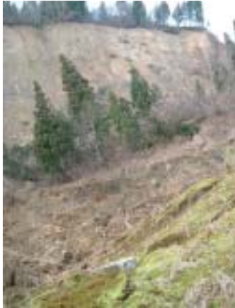
図-3.2.20 池の縁のコケの生えた傾斜面から 滑落崖を見る。
