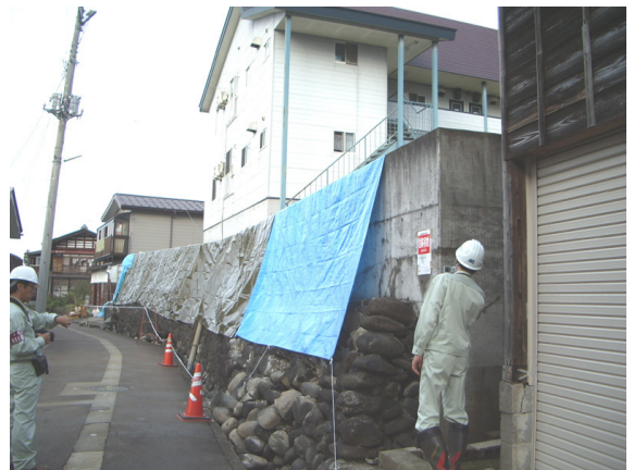
写真 10.3.2 宅地擁壁の被災度判定状況 (川口町)
