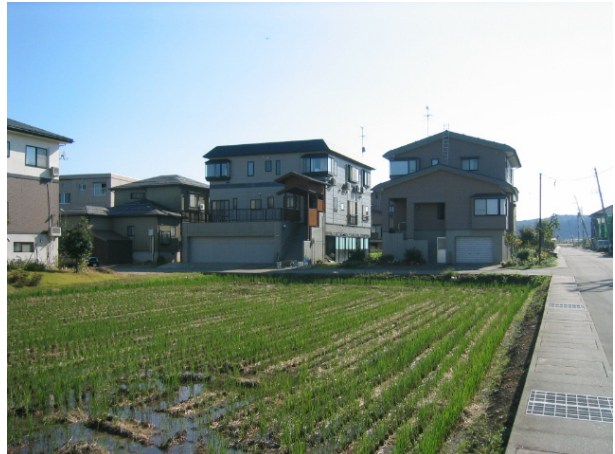
写真 10. 2. 1-12 田んぼの埋立地に建つ高床木造
