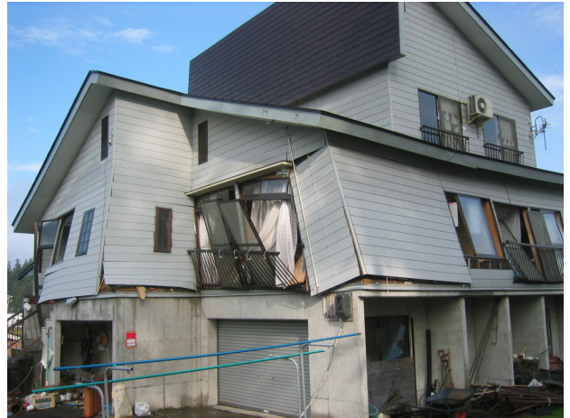
写真 10. 2. 1-1 併用構造の被害
