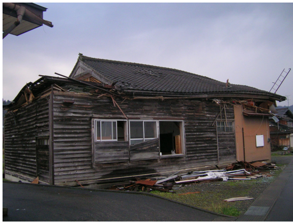
写真 10. 2. 1-9 2階の層崩壊（吉谷地区）
