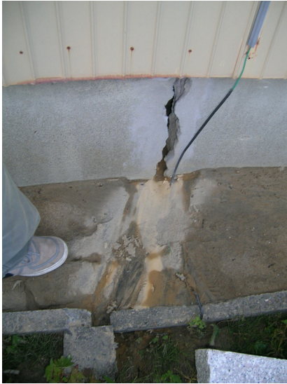
写真 10. 2. 1-15 布基礎の破断 (柿町)
