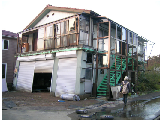
写真 10. 2. 1-14 建物の傾斜 (柿町)
