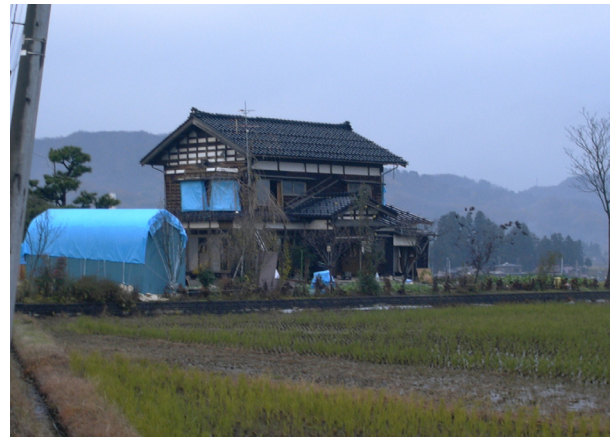
写真 10. 2. 1-10 著しい残留変形（吉谷地区）
