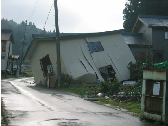
写真 10. 2. 1-19 車庫・納屋の被害（川口町）
