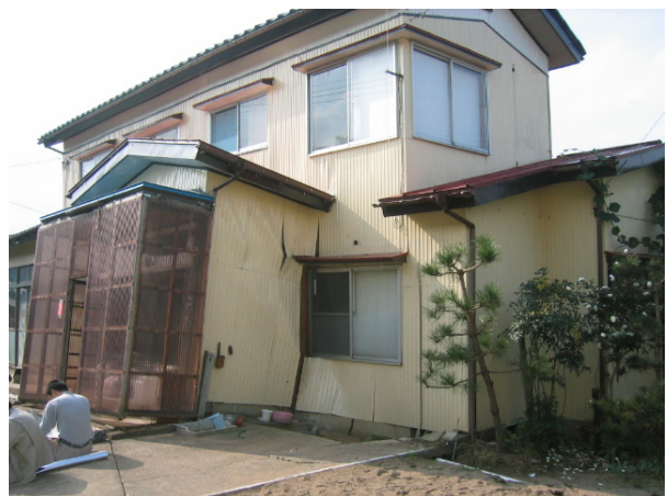
写真 10. 2. 1-18 地盤変状による被害 (柏崎市)
