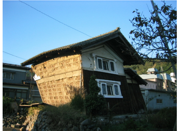
写真 10. 2. 1-20 土蔵の被害（川口町）
