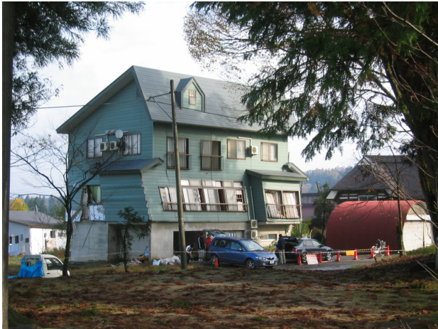
写真 10. 2. 1-1 併用構造の被害
