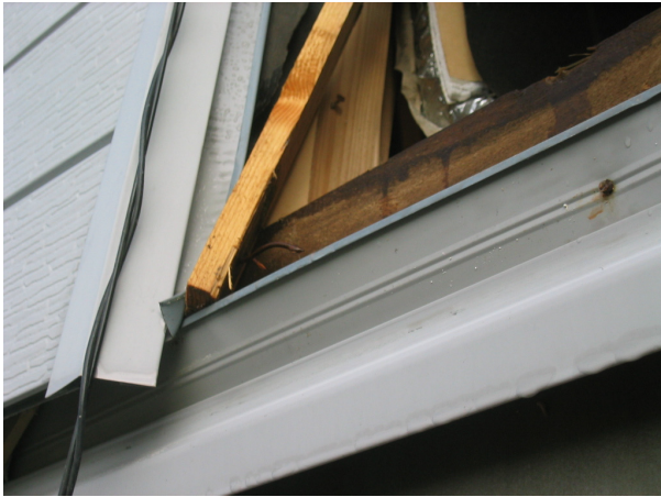
写真 10. 2. 1-3 筋かい接合部の詳細（釘うちの み）
