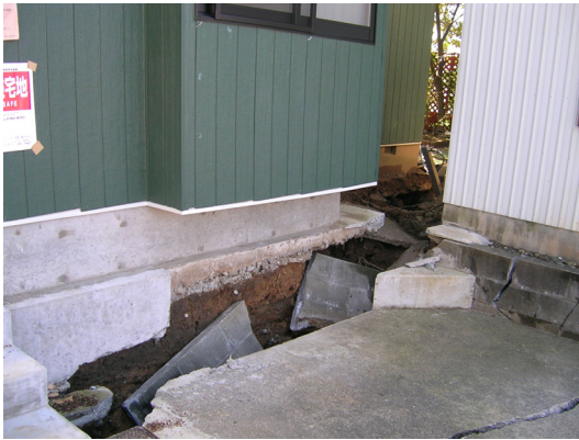
写真 10. 2. 1-13 基礎たたきの分離 (高町)
