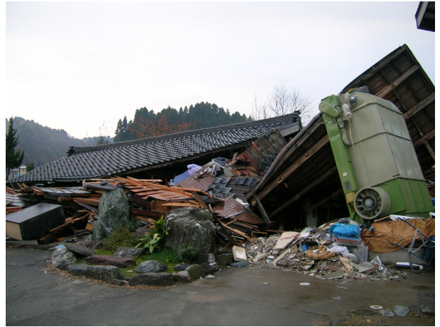
写真 10. 2. 1-8 崩壊した住宅（吉谷地区）
