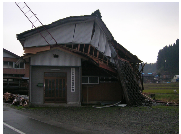
写真 10. 2. 1-22 公民館の被害（小千谷市）
