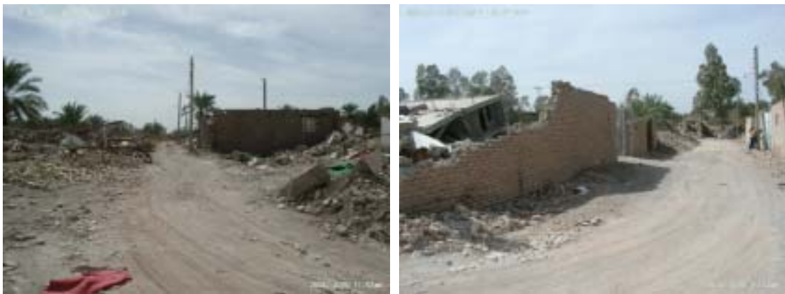
図9 地震被害の方向性の一例（同一地点から撮影） 左：南を望む，右：西を望む 東西方向に面した壁はすべて倒壊，南北方向に面した壁は残っている
