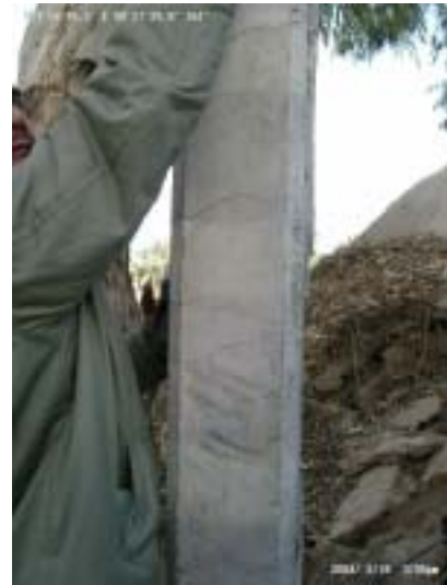
図 5 電柱の曲げ亀裂
