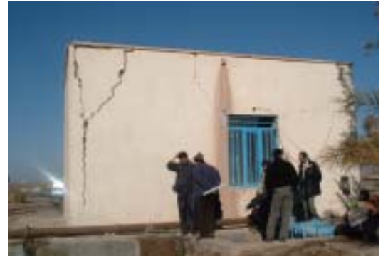
図1 取水ポンプ室の被害*
