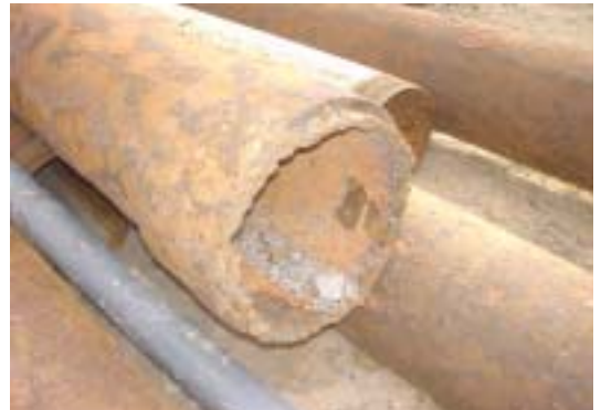
図 6 断層近傍の ACP 管路破損
