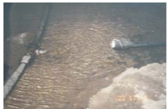
図4 接合部抜け出しによる漏水**
