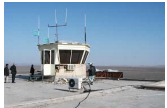
図 14 被災した航空管制塔
