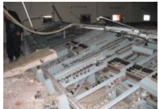
図 11 通信板の棚の倒壊(電話局 2)*
