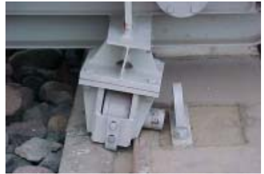
図 9 変電装置のレール滑り*
