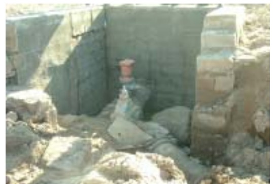
図2 管路接合部の被害*
