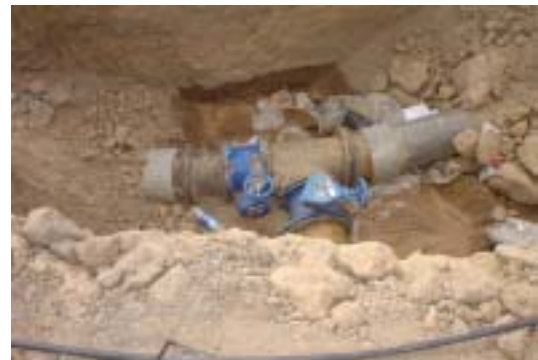
図3 接合部被害箇所の復旧
