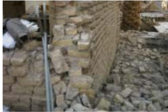
図11 バム市西部の被害建築の基礎状況1
