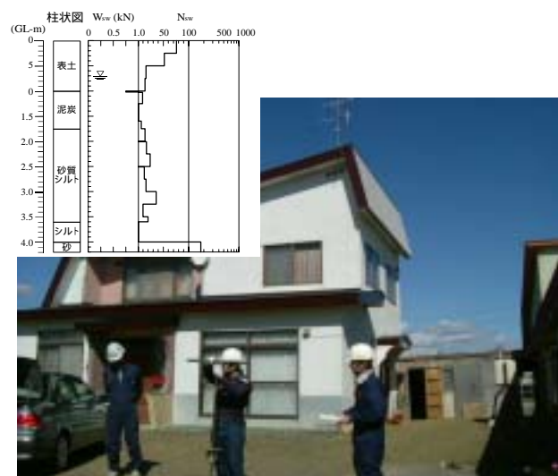
図-8 盛土上で不同沈下した家屋(豊頃町大津)
