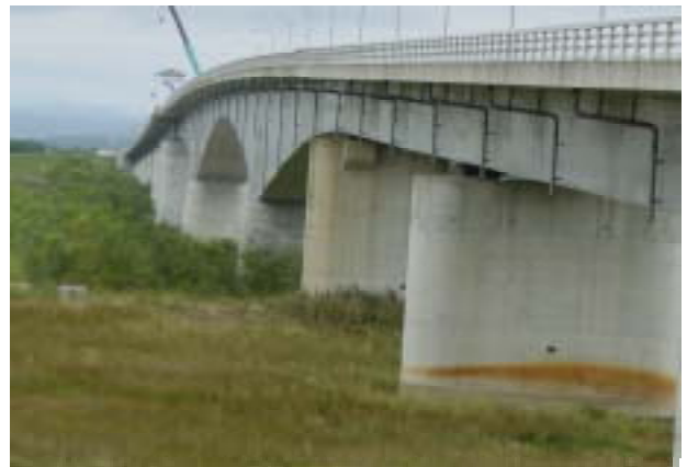
写真2 遠方左岸側の橋軸折れ曲り(十勝河口橋)
