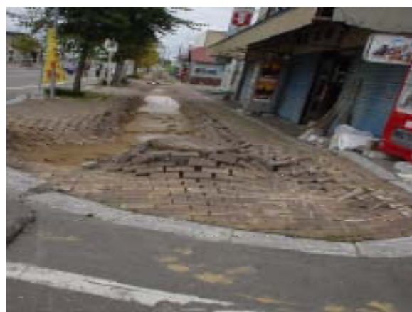
図-5 豊頃駅前歩道の液状化 歩道北側 (帯畜大 土谷教授 撮影)
