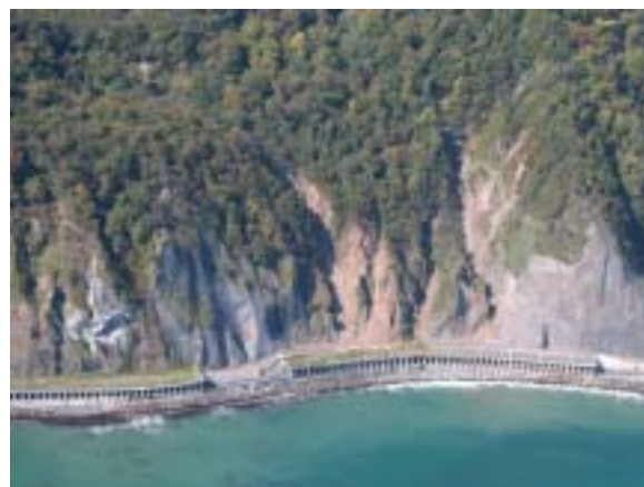
図-6 国道336号線 黄金道路斜面の土砂崩落
