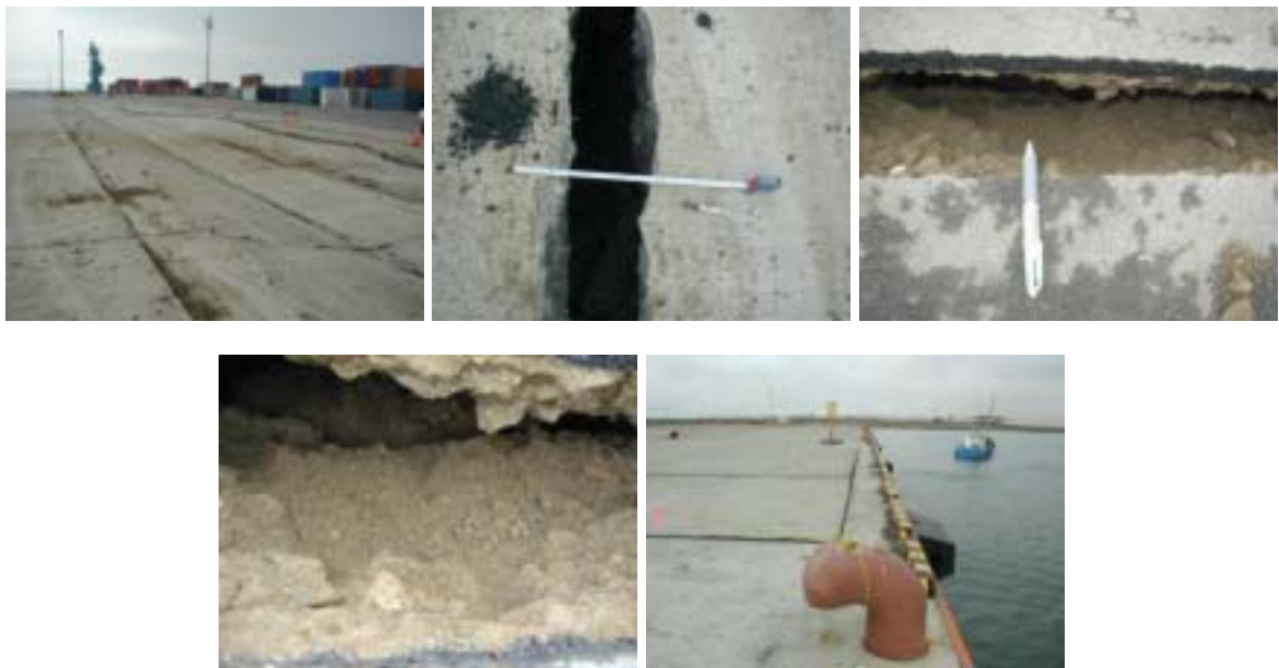
写真-3 釧路西港第四埠頭-10m 岸壁被害状況
