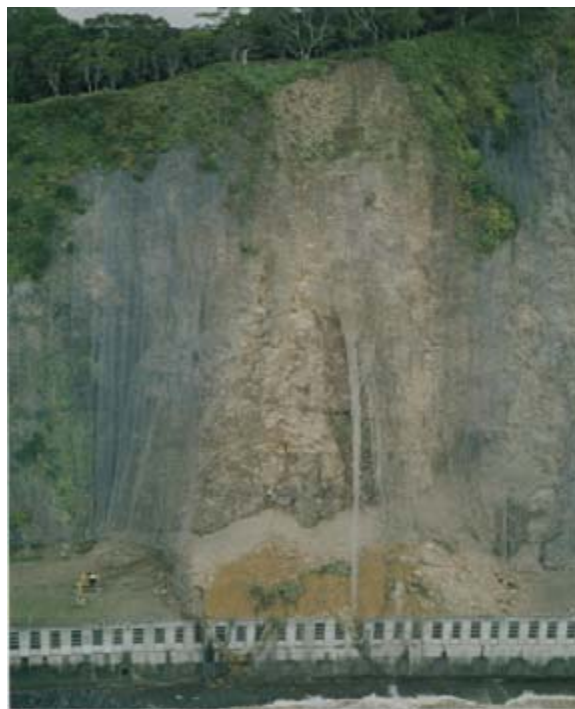
写真11 ほしば覆道上部の崩落(1)
