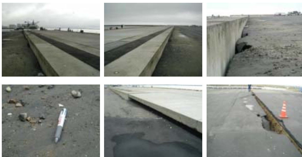
写真-1 釧路西港第四埠頭-14m 被害状況
