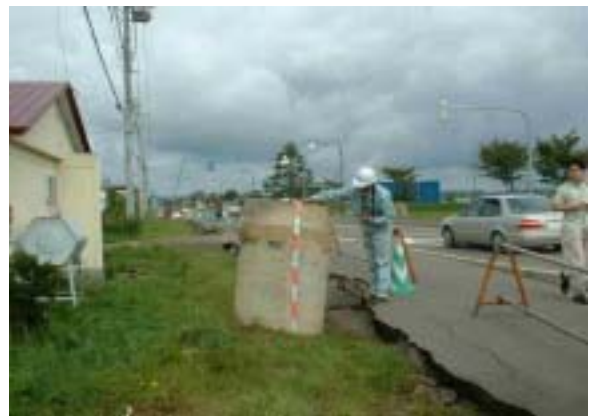
写真1 浮き上がったマンホール(音別町)
