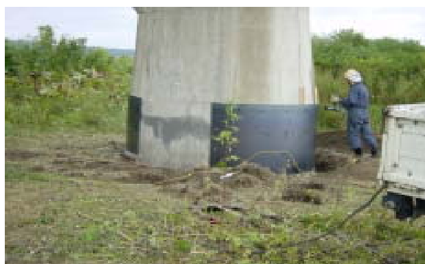
写真6 千代田大橋橋脚の鋼板接着補強
