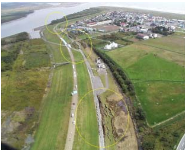
写真 - 1 十勝川右岸大津築堤 (提供：北海道開発局) 崩壊した堤内側の管理用道路
