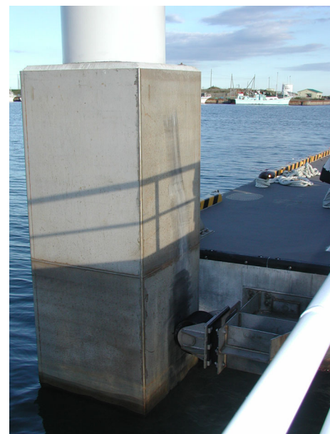
図-4 大津漁港の津波痕跡の例(浮き桟橋)
