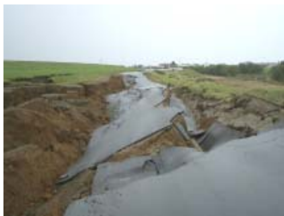
図-4 十勝川 盛土崩壊状況 大津築堤
