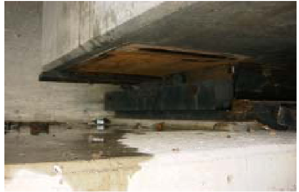
写真1 浦幌側橋台上で上流方向へ桁が移動(67cm、十勝河口橋)
