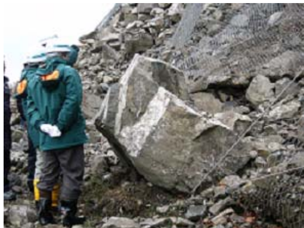
写真10 ほしば覆道上部の落石(大きさ2m)
