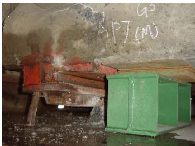
写真8 歴舟橋 支承部の仮受け
