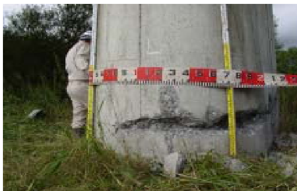
写真4 千代田大橋側径間部橋脚の被害（1）
