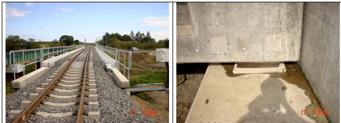
図 5 根室本線新吉野の橋梁
