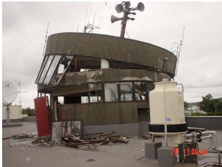
大樹町役場屋上タワーの被害
