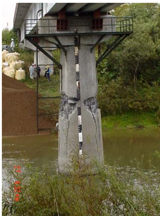
図 7 JR 根室線浦幌川橋梁
