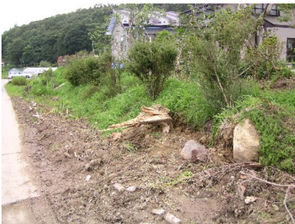
写真 7.7 地滑り泥流の到達部
