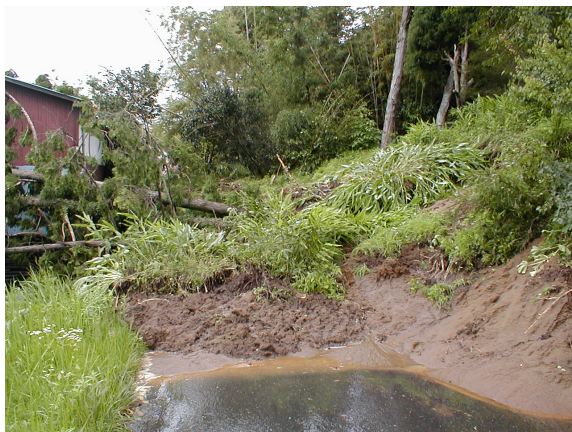
写真 7.2 矢本町大塩地区：この斜面は前震で崩壊した
