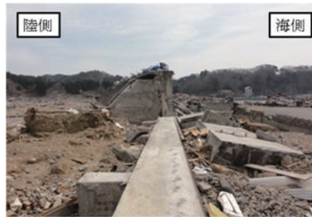
写真1 田老の防潮堤 (右が海側、4月15日撮影)
