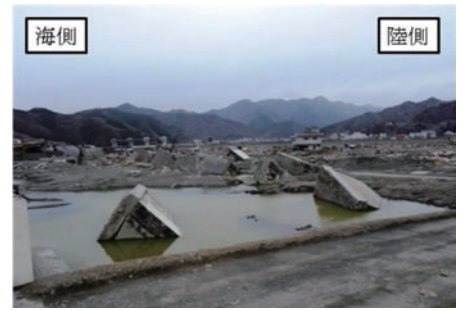
写真2 大槌町の堤防被害 (左が海側、4月8日撮影)
