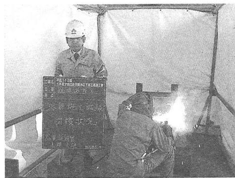
写真-2 現場溶接施工試験
