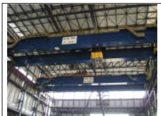
写真 - 4 実験棟内に設置された400トンクレーン
