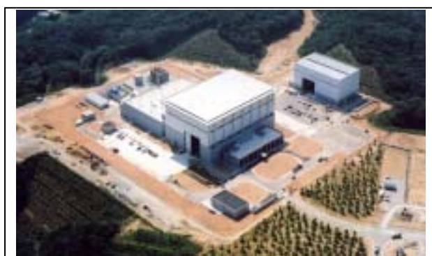
写真 - 3 完成した建物群
