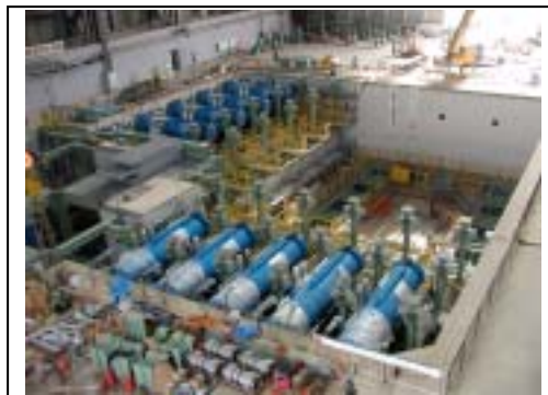
写真 - 5 水平加振機の設置状況
