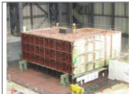
写真 - 6 震動台ブロックの溶接接合状況
