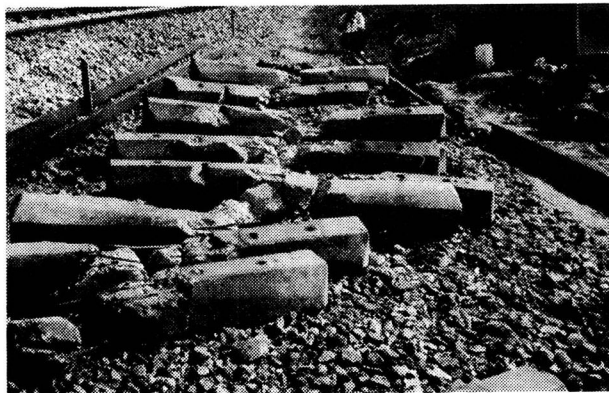
写真－21 撤去されたレールと枕木
