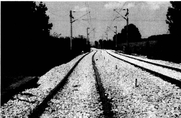
写真-18 Tepetarlaでの鉄道線路の湾曲
