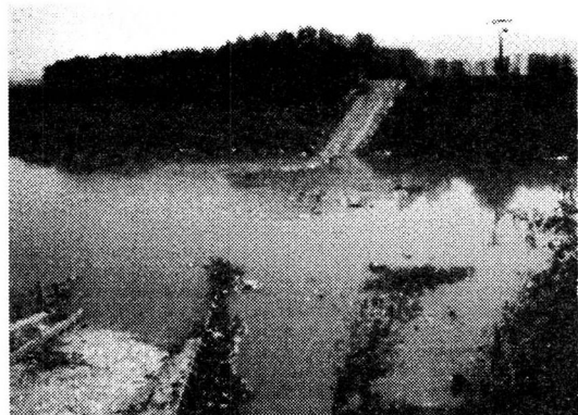
写真-13 No.5橋梁の落橋状況
