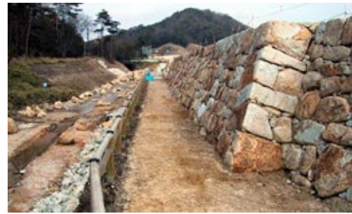
図1. 石積みを用いて付替えられた東海自然歩道
